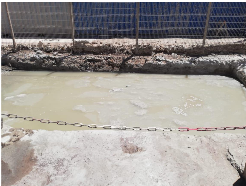
Figura 8.5: Piscina de lavado de descarga de camión mixer
