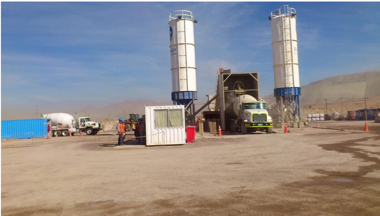
Figura 8.2: Vista amplia de planta de dosificación de PMCHS
