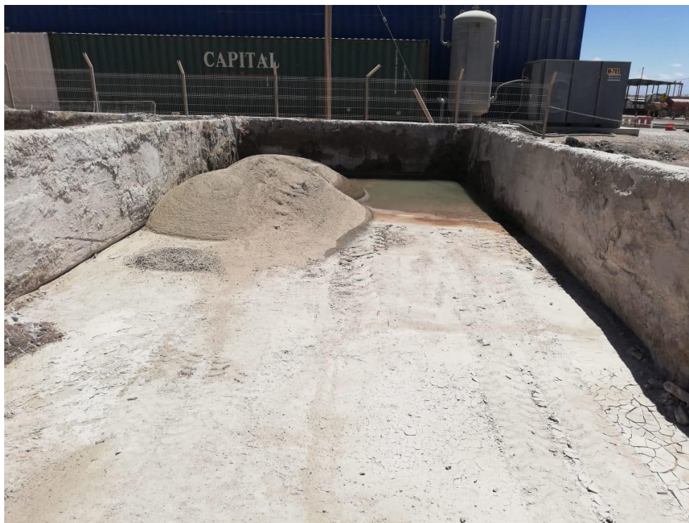
Figura 8.6: Piscina de lavado con presencia de árido
