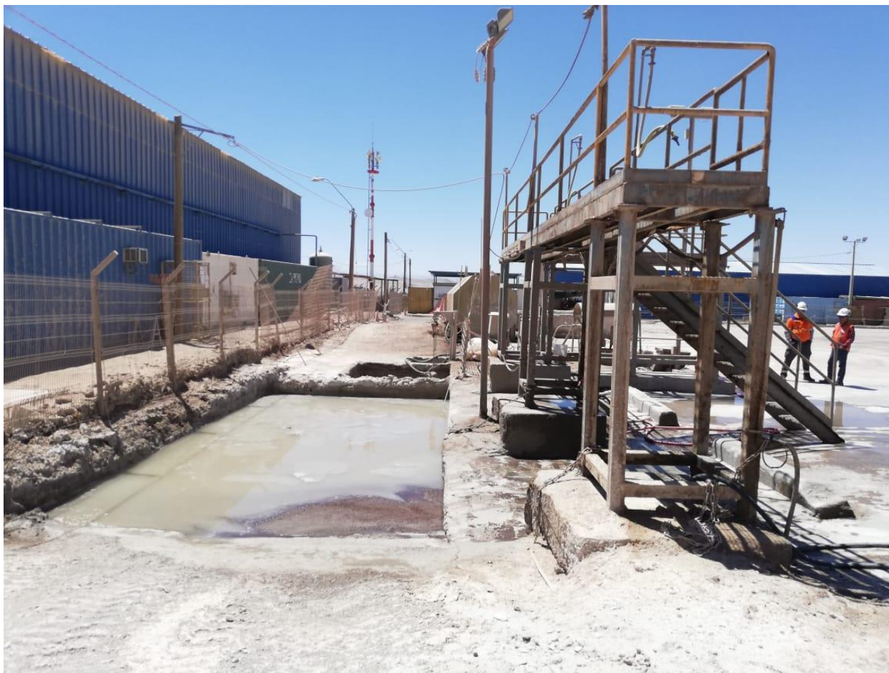
Figura 8.8: Vista completa de la piscina de lavado
