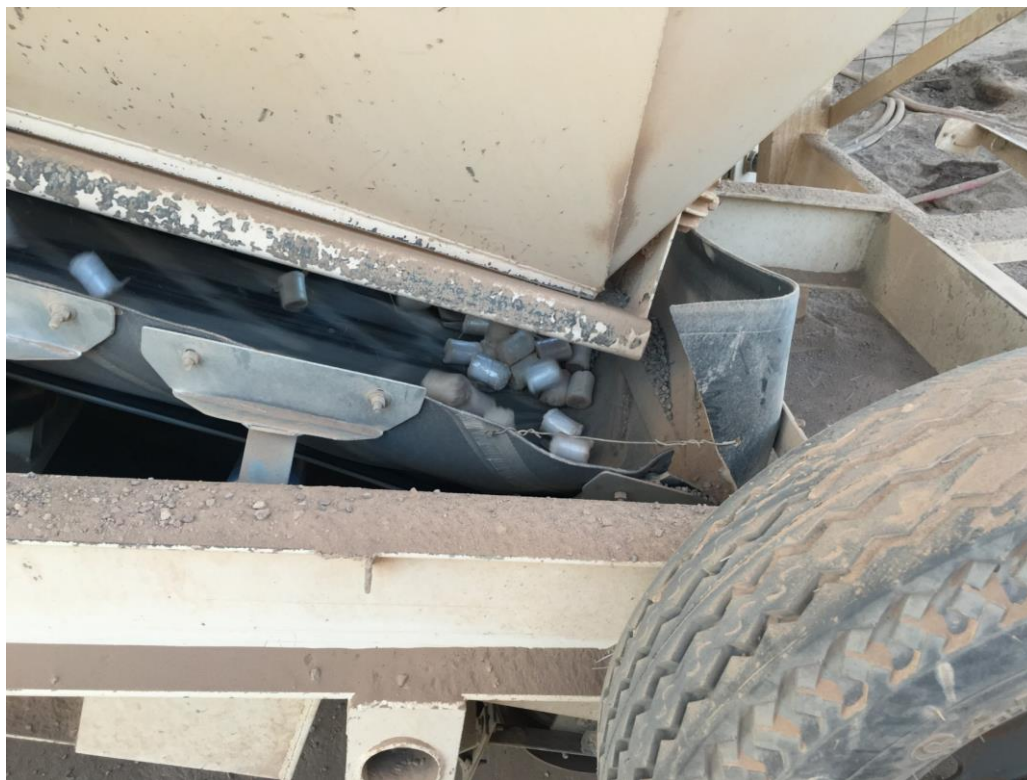
Figura 8.4: Incorporación de fibra de polipropileno a la planta dosificadora
