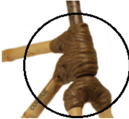
Figura 2.17: Unión de tubos de bambú con tejido de cáñamo cubierto en resina epoxy
