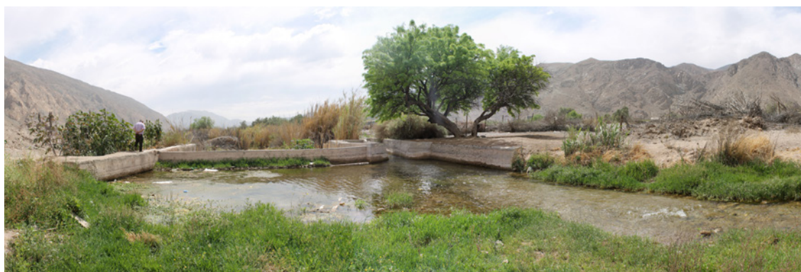
Inicio de la entubación del río Copiapó. Fuente: CPE Atacama.
