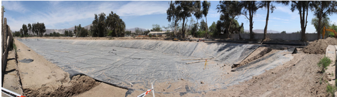
Piscinas de acumulación de agua. Fuente: CPE Atacama.
