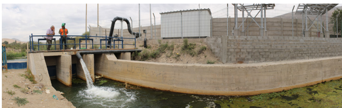
Inicio canal Mal Paso desaladora botando agua al río. Fuente: CPE Atacama.
