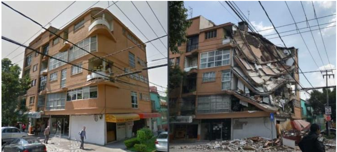
Figura 2.6: Edificio tipo esquina colapsado. (Subrayado MX, 2018b)
