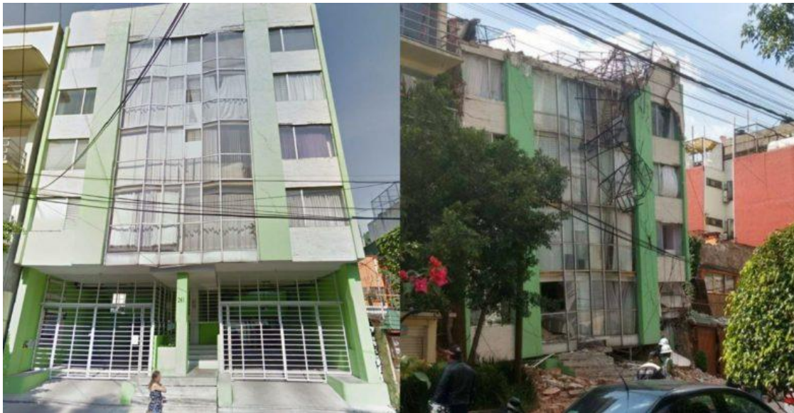
Figura 2.3: Caso de colapso sistema de piso blando en planta baja. (Subrayado MX, 2018c)
