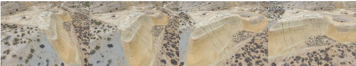
Figura 4-20: Ejemplo de secuencia resumida de fotografías con dron, Depósito A.
