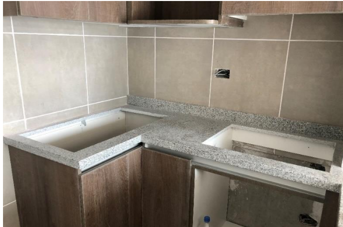
Ilustración 5.16. Cubierta de cocina de granito con perforaciones para lavaplatos y encimera, Obra A.
