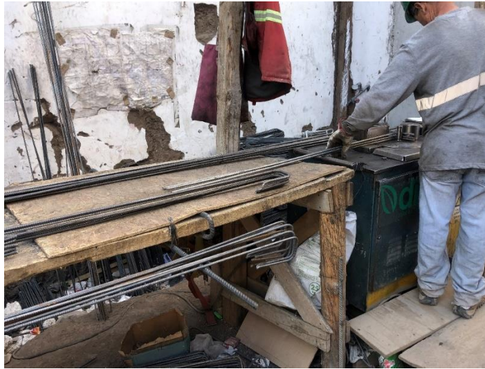
Ilustración 4.5. Trabajador doblando barras de refuerzo en taller de enfierradura, Obra C.
