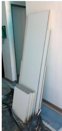
Ilustración 4.9. Tableros predimensionados para estantería de closet, Obra A.
