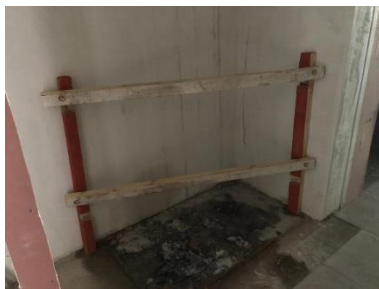
Ilustración 6.1. Barrera de seguridad elaborada con madera pintada, Obra A.
