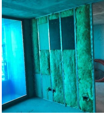
Ilustración 5.4. Reúso de placa fenólica como refuerzo de tabique, Obra A.
