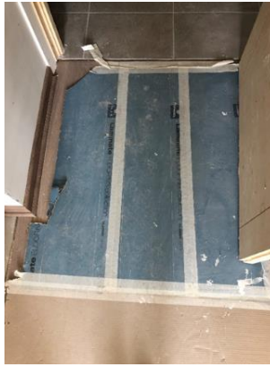
Ilustración 5.6. Cajas de cartón reutilizadas para protección del piso fotolaminado, Obra A.
