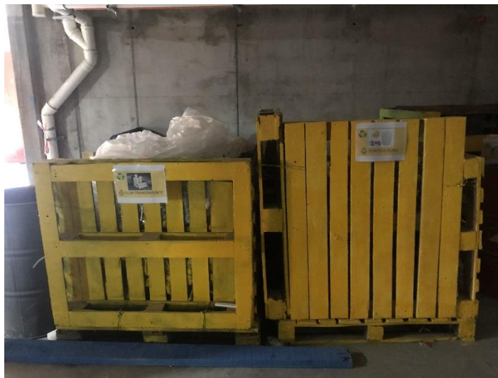
Ilustración 3.16. Acopio de plásticos en punto limpio de Obra E.
