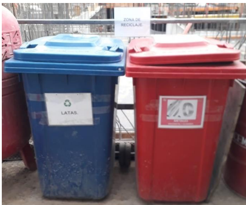
Ilustración 3.12. Contenedores de latas y aluminio sin los colores adecuados, Obra C.
