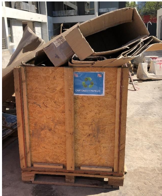
Ilustración 3.8. Acopio de cartón, Obra B.
