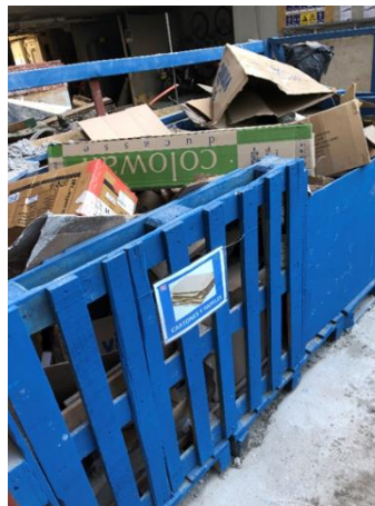
Ilustración 5.3. Sector de acopio de cartón, confeccionado con pallets de madera reutilizados, Obra A.
