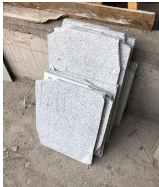
Ilustración 5.17. Restos de granito de cubierta de cocina acopiados informalmente, Obra A.
