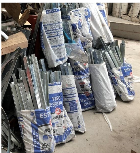
Ilustración 4.11. Excedente de perfiles metálicos acopiado para reciclaje, Obra A.
