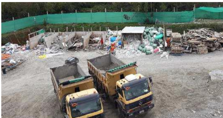
Ilustración 3.4. Sector de acopio Axis Desarrollos Constructivos. Fuente: Axis Desarrollos Constructivos, 2018.
