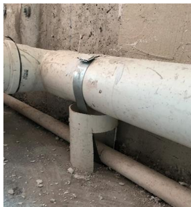
Ilustración 5.10. Tubería adaptada para soporte permanente de ducto de descarga de WC, Obra A.
