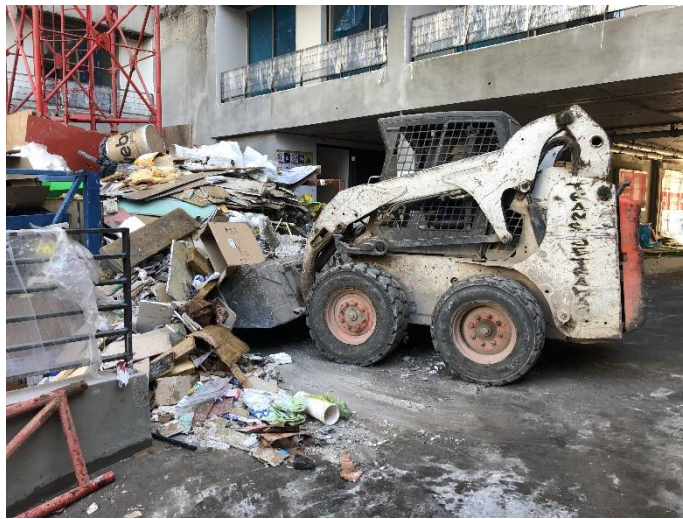
Ilustración 3.5. Acopio de escombro siendo vaciado por cargador frontal, Obra A.
