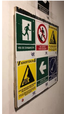
Ilustración 5.5. Reúso de placa fenólica para soporte de señalética, Obra A.
