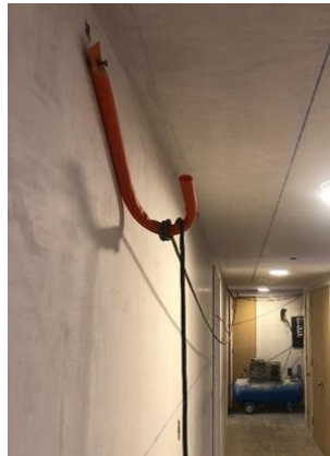
Ilustración 5.9. Tubería de PVC adaptada para sujeción temporal de cables, Obra A.
