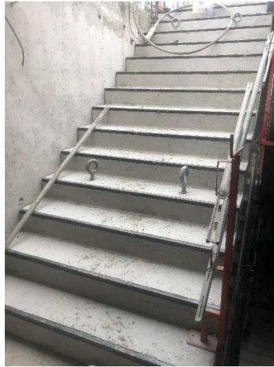
Ilustración 4.1. Escalera prefabricada en instalación, aún con ganchos de izaje, Obra A.
