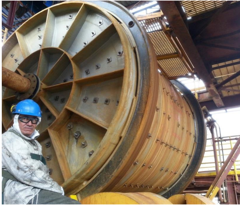
Figura 2.2: Reactor de tambor rotatorio utilizado en el proceso de cementación en Minera Los Pelambres.
