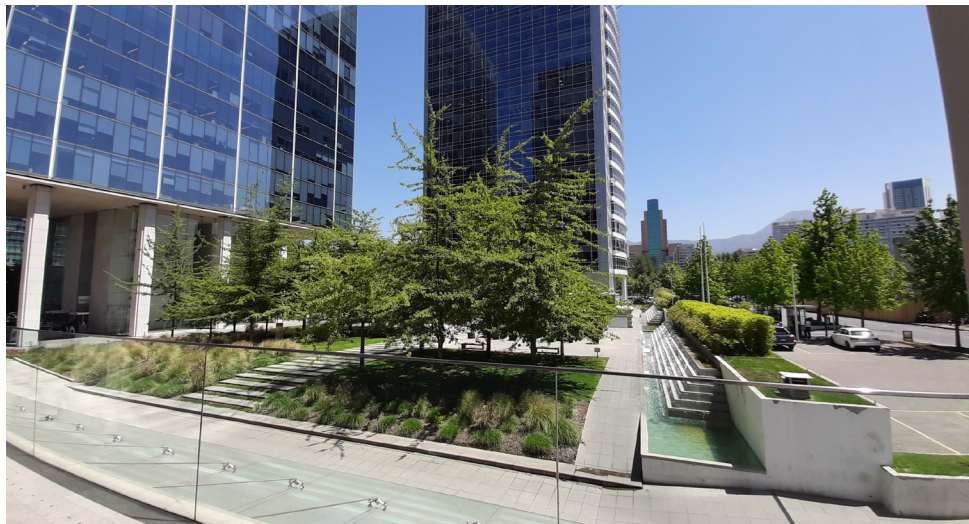
Imagen N°26. Edificio Nueva Las Condes. Fuente: Elaboración propia
