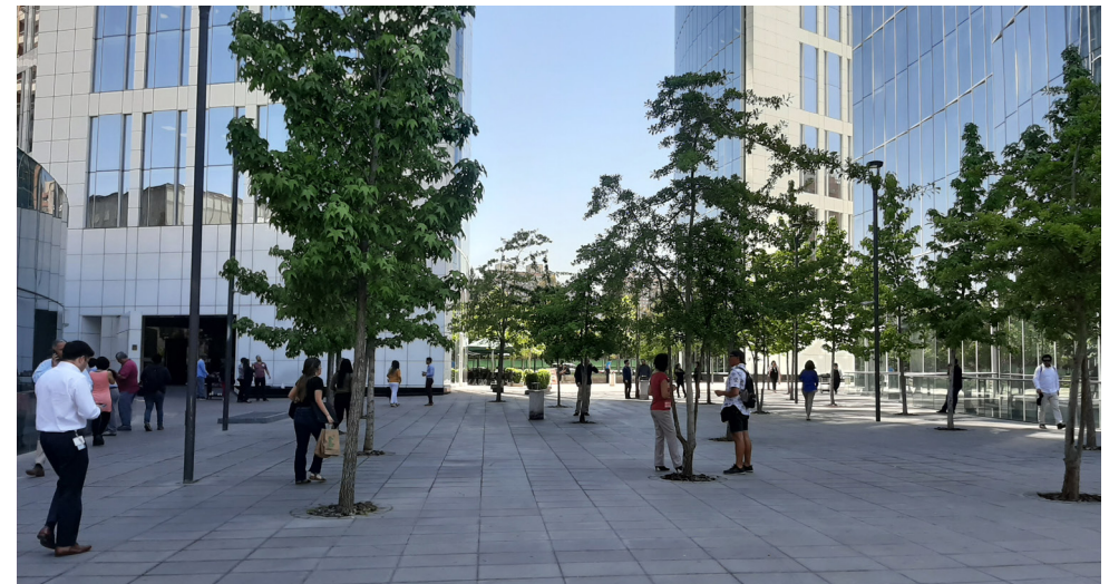
Imagen N°28. Edificio Nueva Apoquindo. Fuente: Elaboración propia
