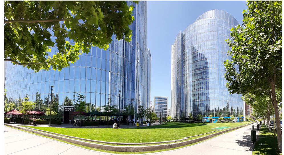
Imagen N°27. Edificio Nueva Apoquindo. Fuente: Elaboración propia
