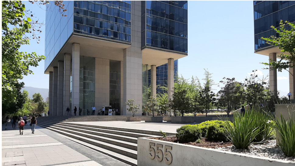
Imagen N°25. Edificio Nueva Las Condes. Fuente: Elaboración propia
