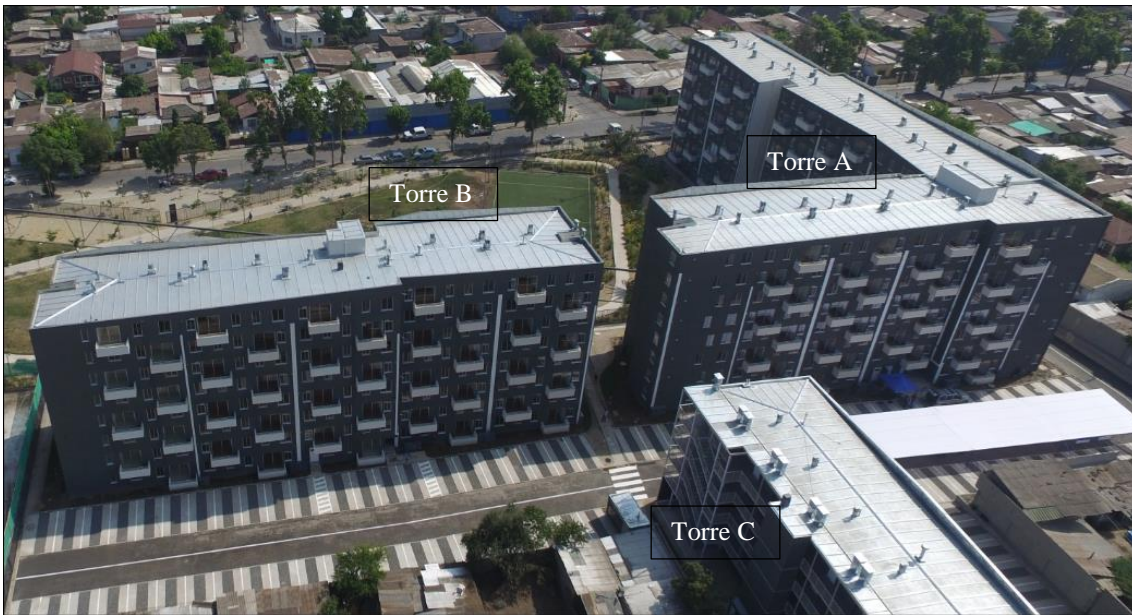
Fig. 5.2 – Identificación de las Torres A, B y C, vistas de Sur a Norte.
