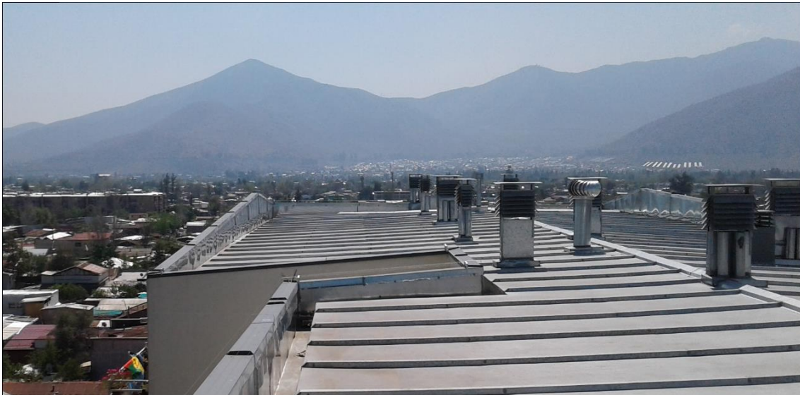
Fig. 5.4 - Vista hacia el norte, del área 2 al área 1, en que se aprecia la estructura del techo y los ductos de ventilación.
