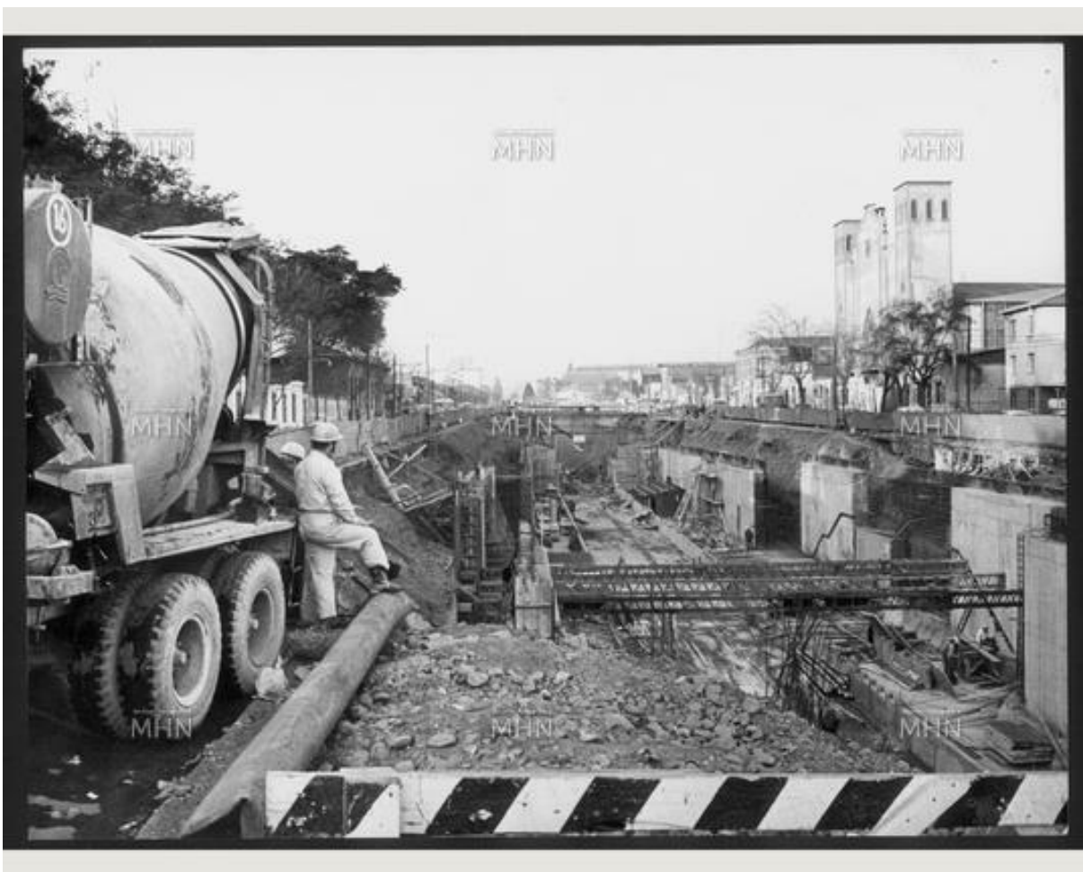
Fotografía 1: SAN MARTIN, M. [1971]. Excavación del metro, en la Alameda a la altura Bernal del Mercado. [fotografía] 1 foto. Papel positivo monocromo. [ http://www.fotografiapatrimonial.cl/p/10889 ]
