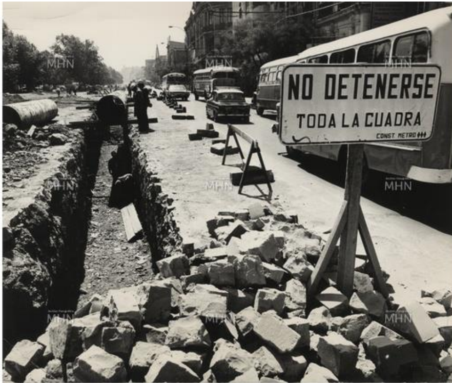
Fotografía 5: TORRENTE, E. [n.a]. Excavaciones en la Alameda con motivo del Metro de Santiago. [fotografía] 1 foto. Papel positivo monocromo. [ http://www.fotografiapatrimonial.cl/p/47616 ]
