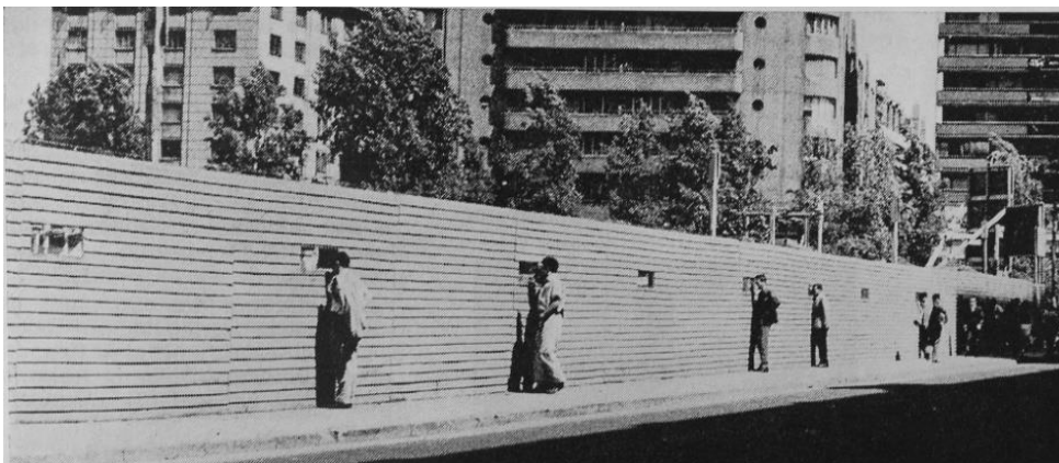
Fotografía 6: AUTOR DESCONOCIDO. [1964, mal fechado]. Construcción Metro de Santiago en 1964. [fotografía] 1 foto. [ https://www.enterreno.com/moments/construccion-metro-de-santiago-en-1964 ]
