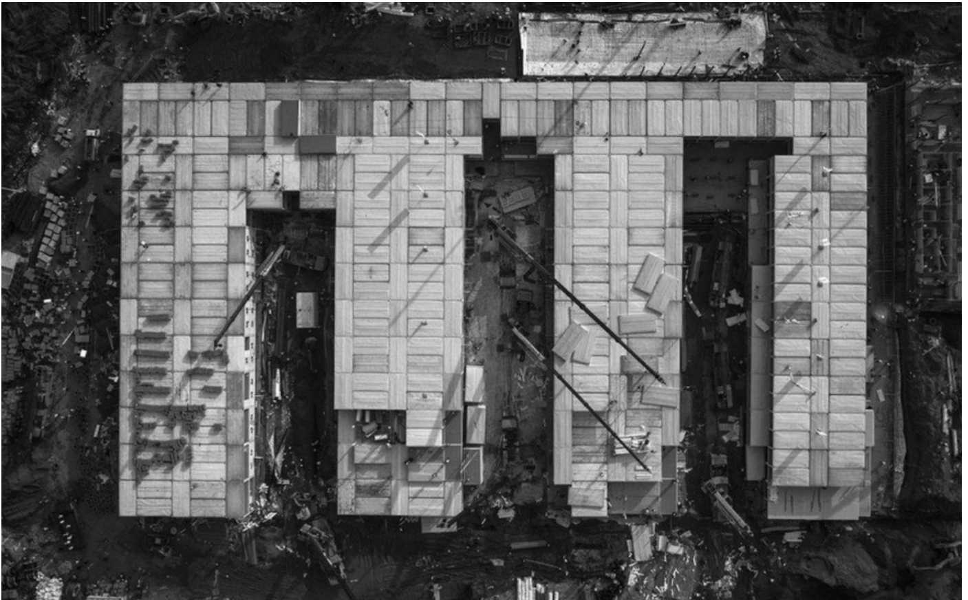
(14) Construcción de hospital de Wuhan.
