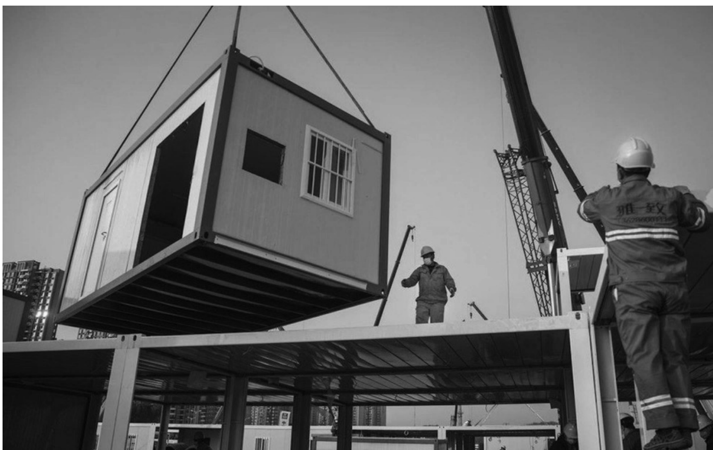
(12) Ensamble de contenedor del hospital de Wuhan.
