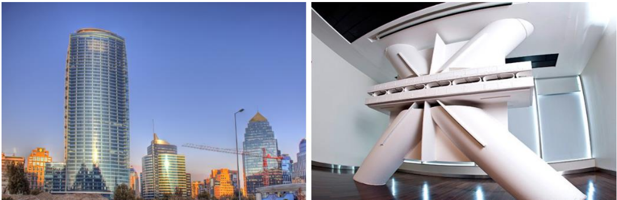
Figura 2-2: Torre Titanium La Portada y Disipador Sísmico del tipo hysterético implementado (EMB Construcción, 2012).
