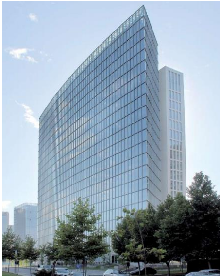
Figura 2-4: Edificio Parque Araucano Santiago (Chapple, 2008).
