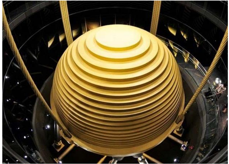
Figura 2-7: Disipador de Masa Sintonizada de tipo péndulo, Torre Taipei 101 (Encyclopedia Britannica, 2017).
