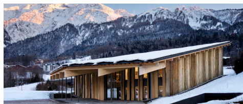
Figura 26. Campamento Base Mont-Blanc. Fuente: www.plataformaarquitectura.cl .
