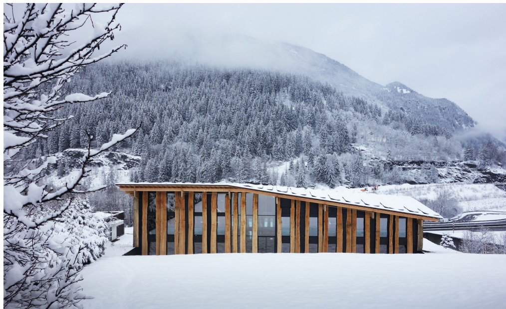
Figura 25. Campamento Base Mont-Blanc. Fuente: www.plataformaarquitectura.cl .
