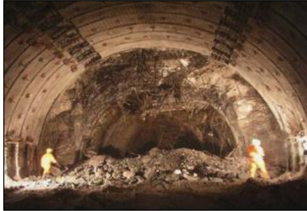
Ilustración 2.33. Preparativos para la reconstrucción de la estación multifuncional de Faido debido al Squeezing, (Herrenknecht, 2010).
