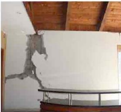
Figura 112: Daño eje 22 en el primer piso Fuente: (a) [21]; (b) fotos inspección en terreno
