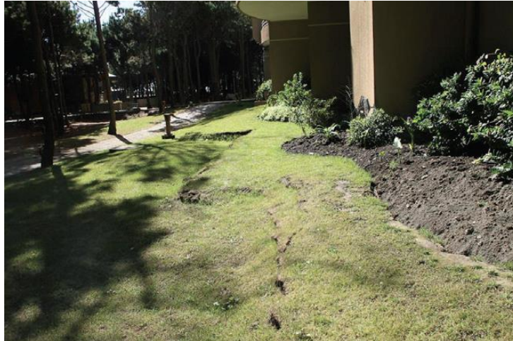
Figura 107: Asentamiento del suelo en la cara mirando al océano [22]
