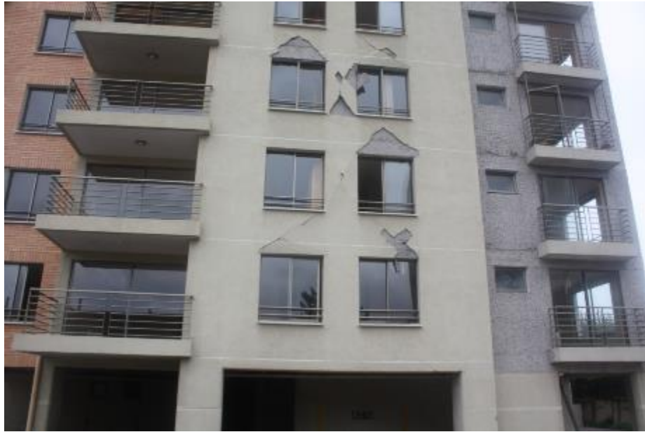
Figura 71: Fachada nororiente (1) Fuente: Fotos inspección en terreno
