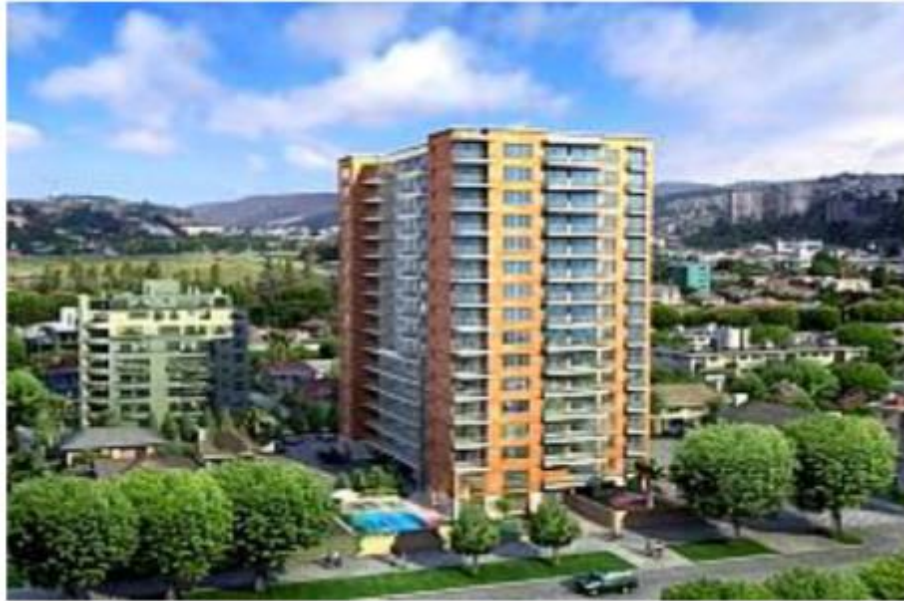
Figura 61: Vista general del edificio [18]
