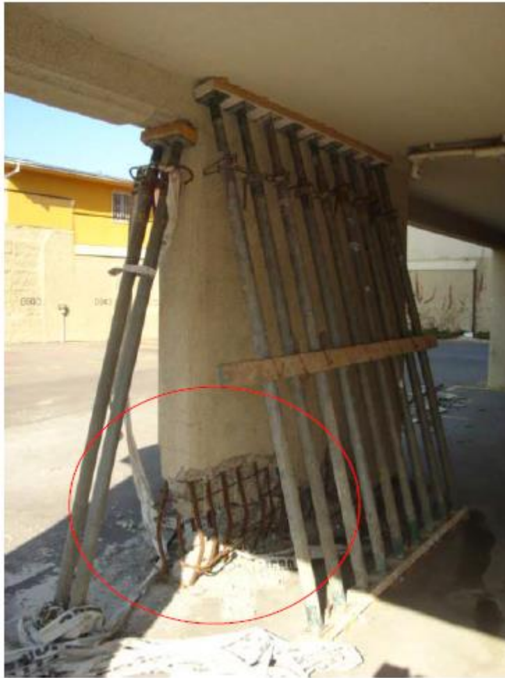
Figura 76: Refuerzos en muro dañado eje 16 [17]
