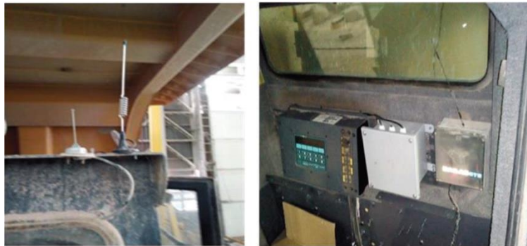
Ilustración 12. A la izquierda se observa la antena de transmisión sobre la cabina del camión, a la derecha la unidad electrónica montada dentro de la cabina
