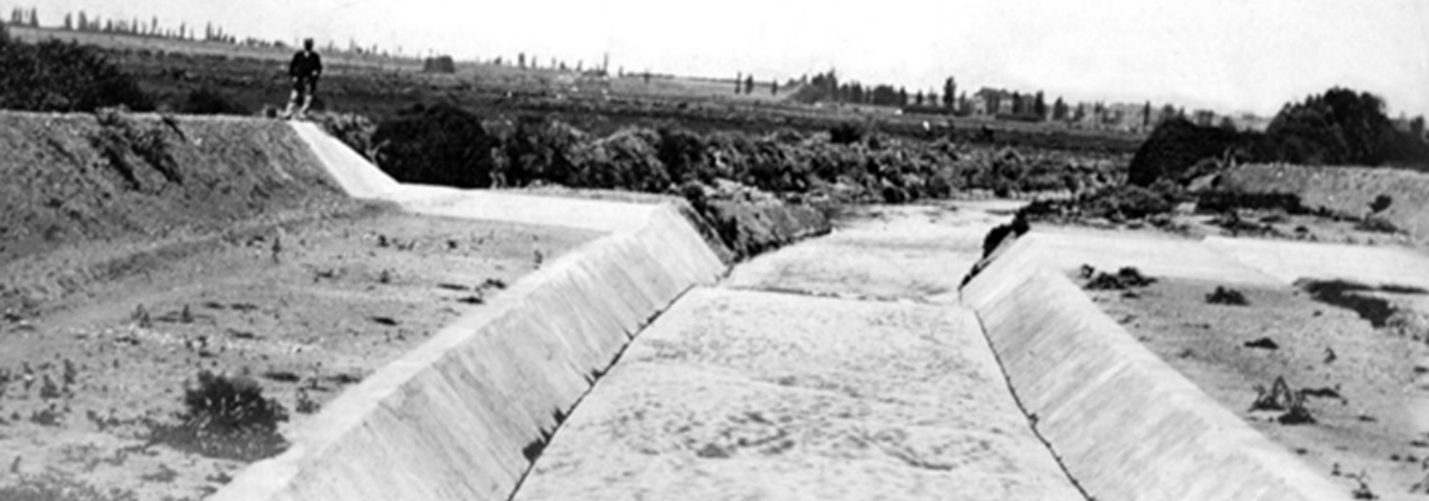
IMAGEN 14. Canales de descarga. Canal AH intersección con el zanjón de la Aguada (enero 1909) - Fuente: Fernandez, 2015.
