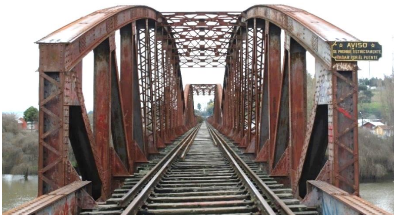
Figura N° 24. Puente ferroviario sobre río Chol Chol, Nueva Imperial.
