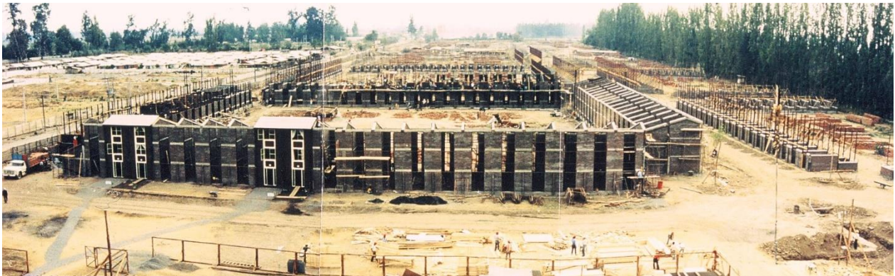
Figura 13: visita a obra Conjunto Los Sauces. Fuente: Gentileza arquitecto Francisco Vergara.
