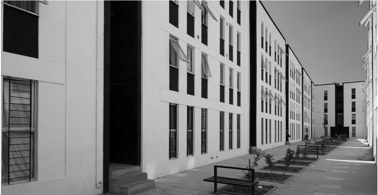
Figura 31: visita interior del conjunto. Fuente: Gentileza arquitecto Iván Theoduloz.
