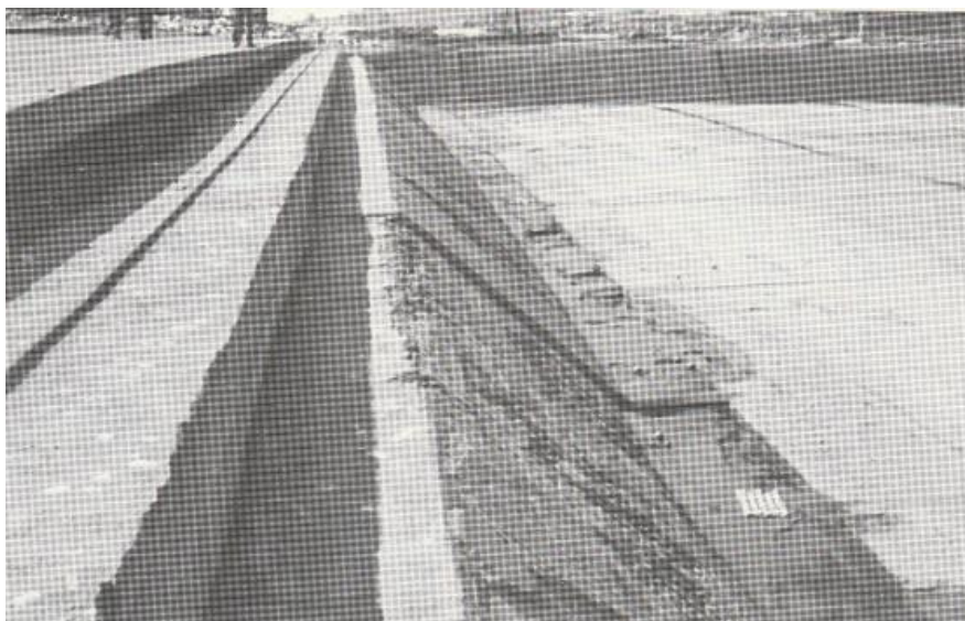
Figura 3.23: Afloramiento de arena en depósito de carbón (Monge et al, 1986)
