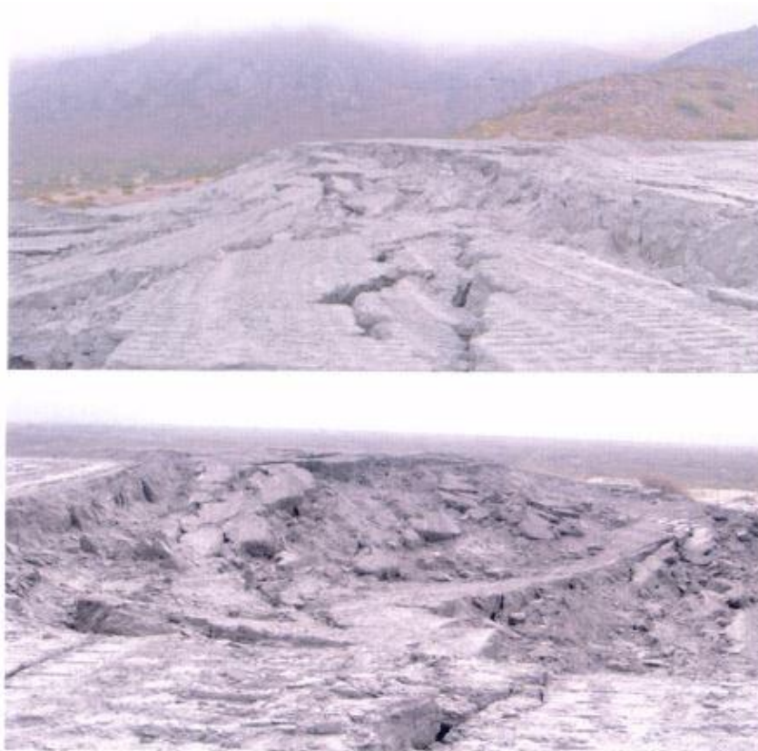
Figura 3.44: Fallas Observadas Tranque Bellavista (Yadlin et al, 2012)
