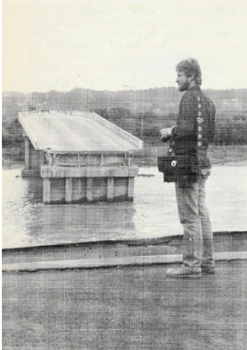
Figura 3.39: Vista hacia el sur del puente Lo Gallardo (Monge et al, 1986)
