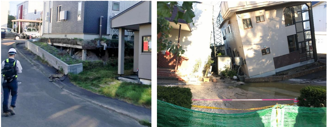
Figura 2.10: Daños en la prefectura de Hokkaido, Japón
