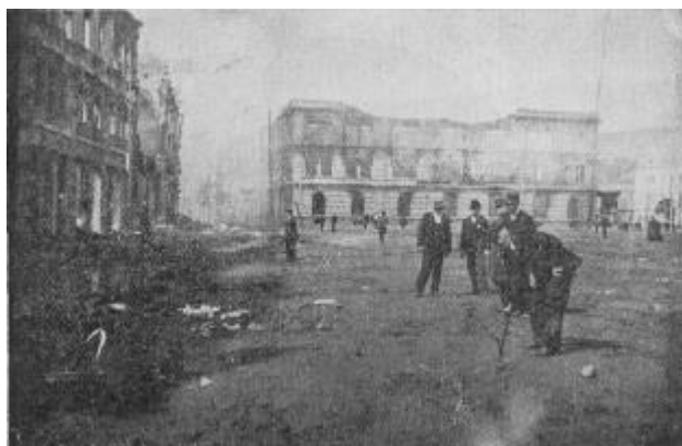
Figura 3.4: Medición de las grietas (Rodríguez y Gajardo, 1906)
