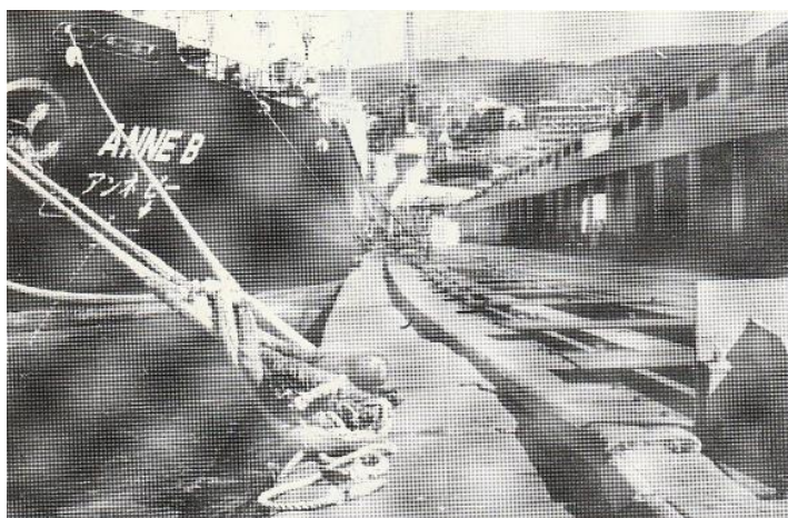
Figura 3.38: Daños en el sitio 8 (Monge et al, 1986)
