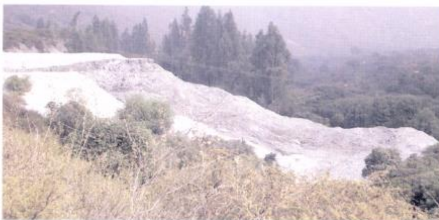
Figura 3.45: Falla en Tranque Veta de Agua. (Yadlin et al, 2012)
