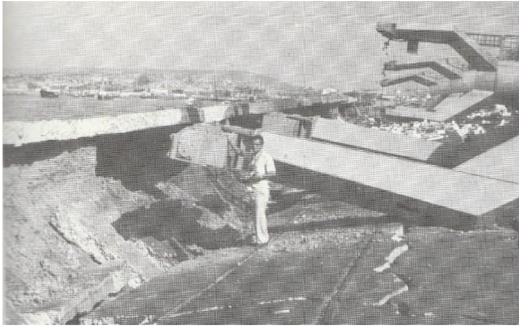
Figura 3.24: Desplazamiento del molo de bloques de concreto (Monge et al, 1986)
