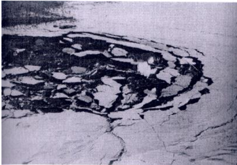
Figura 3.9: Detalle de la zona colapsada en tranque viejo. "El hundimiento se da en el material limoso por debajo de la costra arcillosa superficial de unos 2 cm de espesor, por expulsión de agua de saturación" (Varela y Vicencio, 1965).
