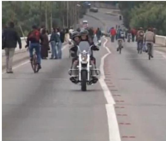
Figura 3.42: Deformaciones en el Puente Lo Gallardo (Verdugo y González, 2015)
