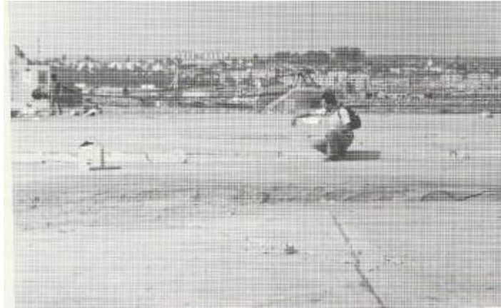
Figura 3.26: Afloramiento de arena en explanada de Sitio 3 (Monge et al, 1986)
