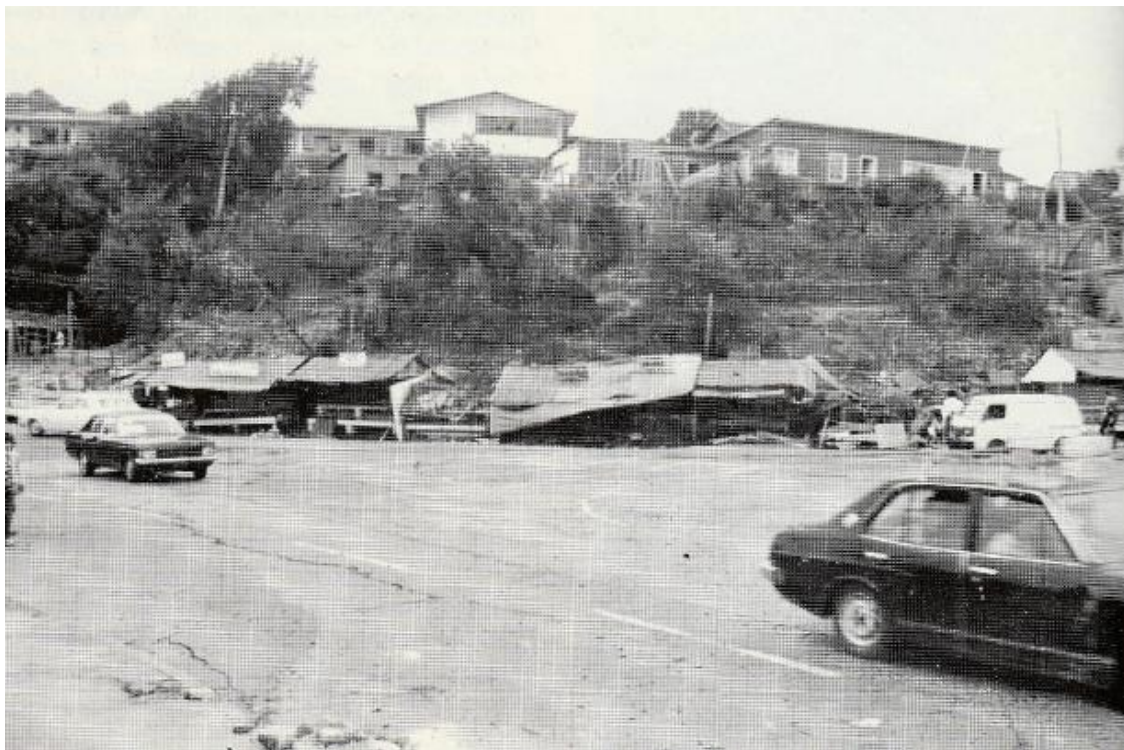
Figura 3.27: Sector plaza San Antonio, deslizamiento de dunas y fracturamiento de pavimento (Monge et al, 1986)
