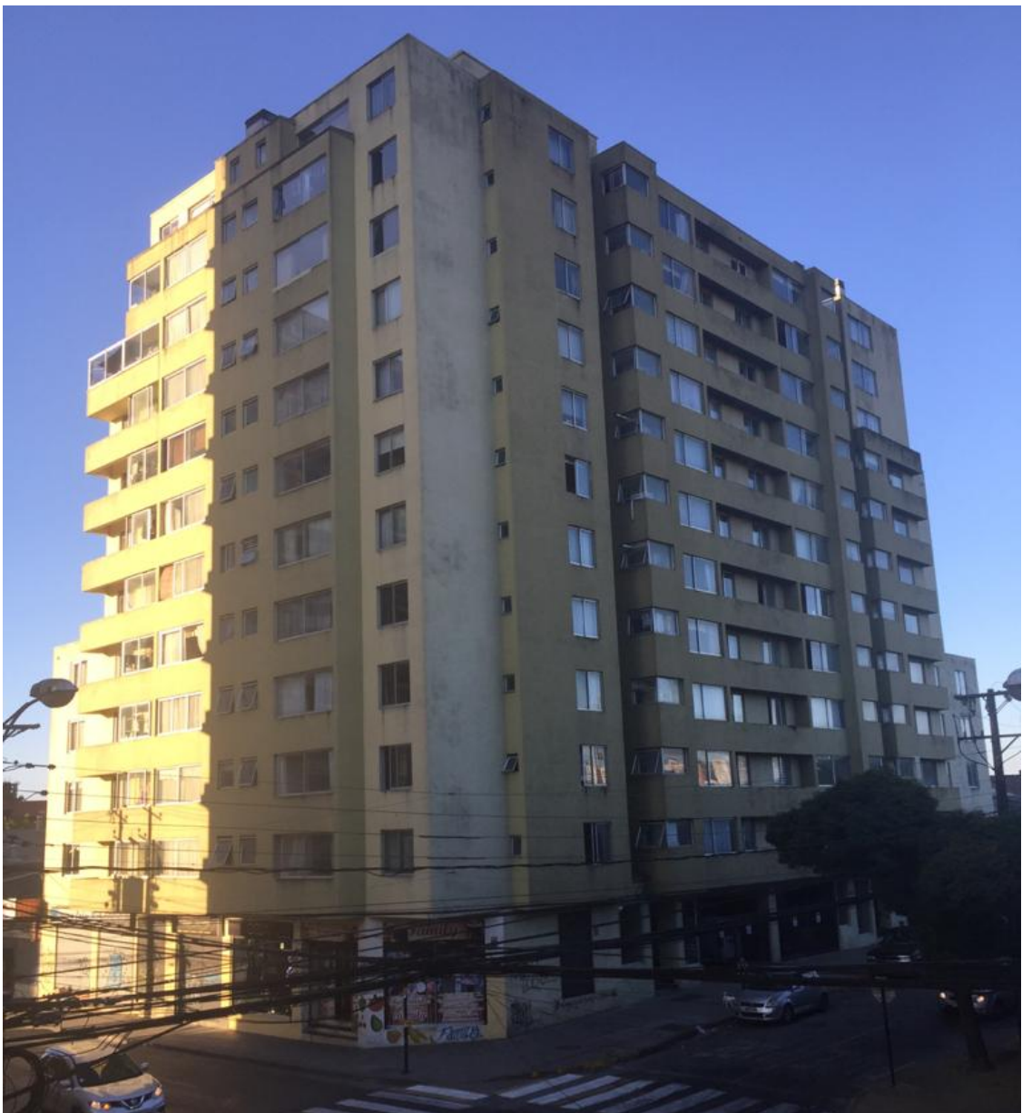
Figura 37: foto edificio Cerro Amarillo. Fuente: Elaboración Propia
