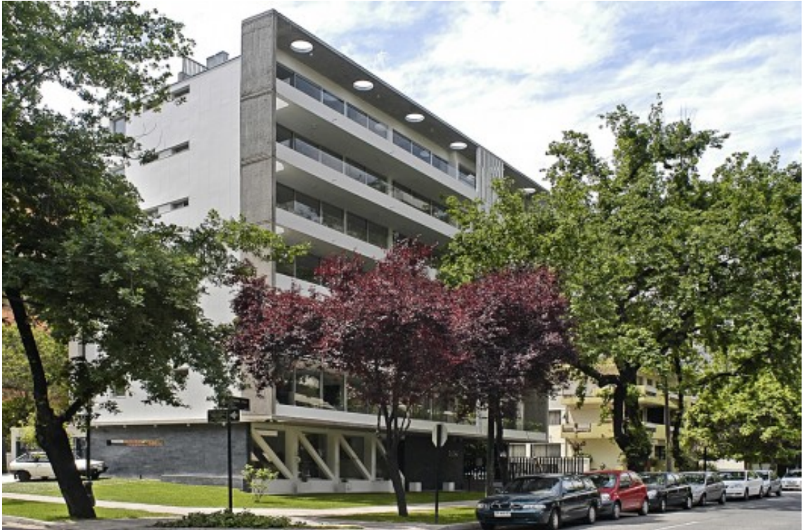
Figura 15: Fotos edificio Ger Carmen Sylva. Fuente: Elaboración Propia
