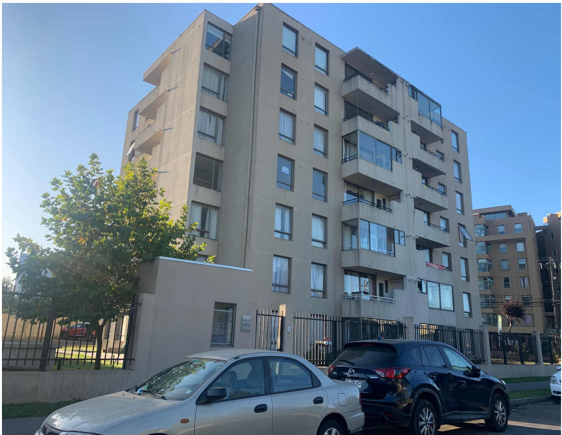
Figura 35: foto edificio Canto del Valle. Fuente: Elaboración Propia
