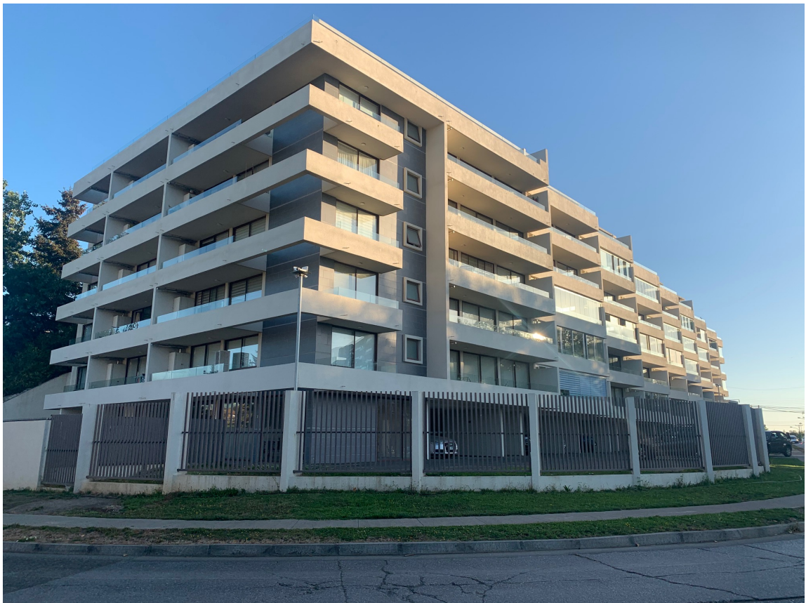
Figura 28: foto edificio Avenida San Andrés. Fuente: Elaboración Propia
