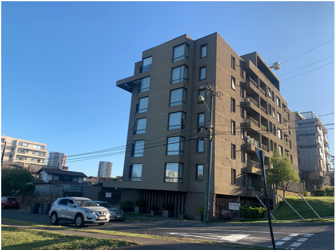
Figura 31: foto edificio Amanecer Lomas.
