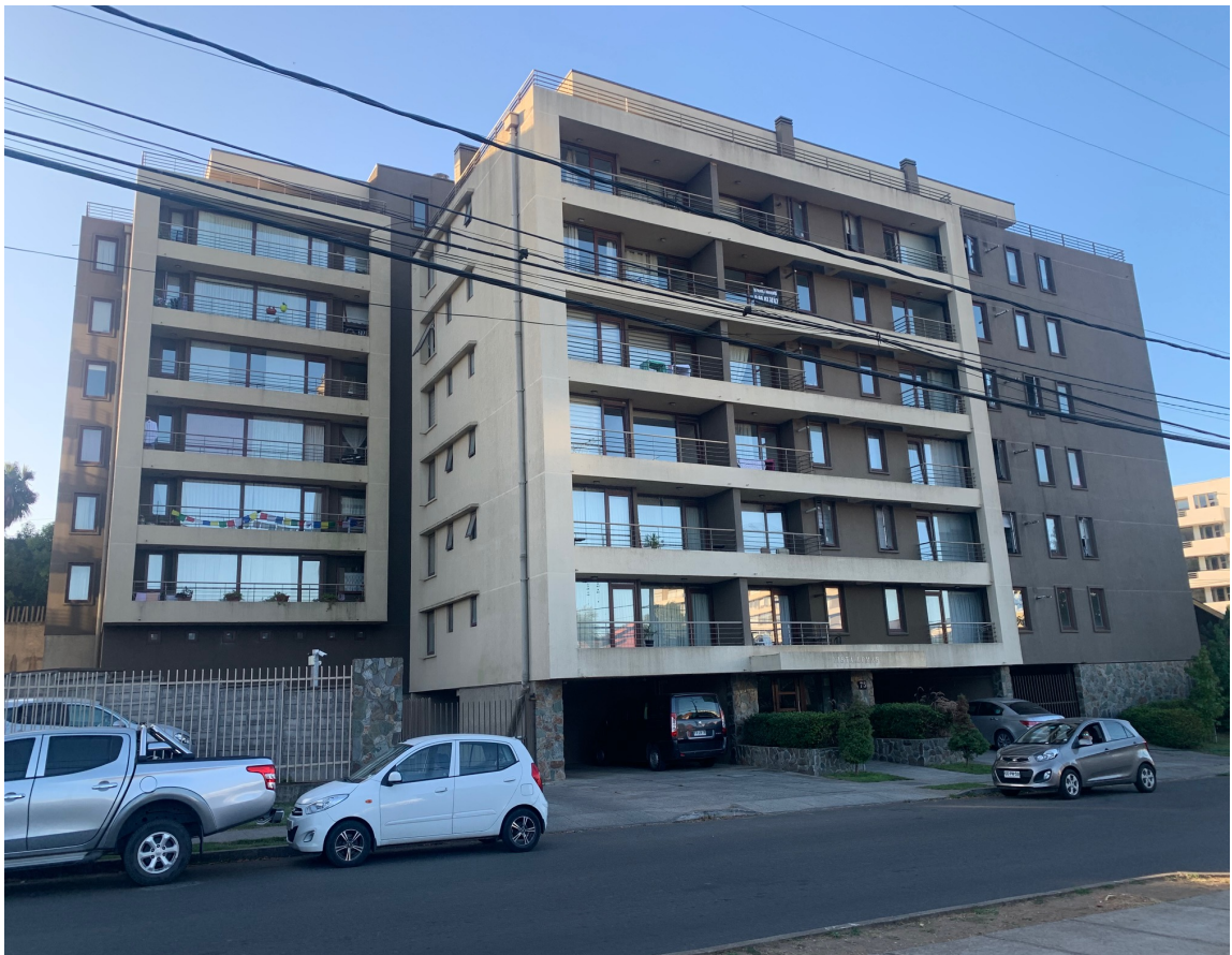
Figura 36: foto edificio Vista Lomas. Fuente: Elaboración Propia
