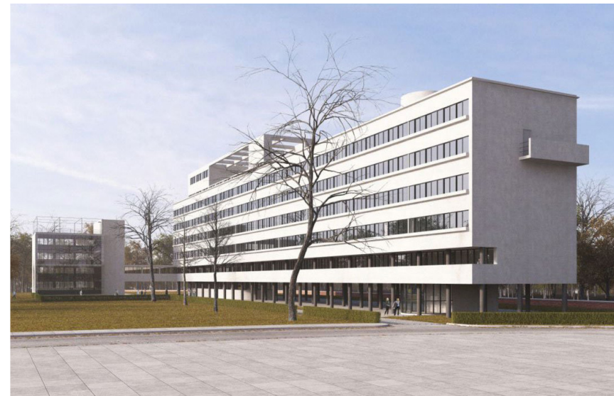
Imagen N°8 y 9 Edificio Narkomfin (abreviatura de Comisariado del Pueblo para las Finanzas) en Moscú entre 1928 y 1932. Fuente: (Edificio Narkomfin—Ficha, Fotos y Planos, s. f.)
