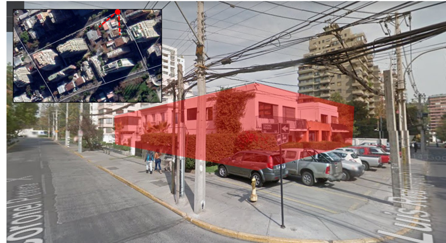
Imagen N°93 Vista esquina Coronel Pereira con Calle Luis Rodríguez Velasco. Fuente: Elaboración propia con datos (Google Maps, s. f.)
