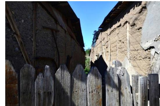
Figura 110: Izquierda: Sistema constructivo típico presente mayoritariamente en el módulo base de las viviendas tipo 1 de Coya, extraído del expediente de declaratoria. Superior derecha: Detalle de tabiquería rellena con adobe en pandereta, presente en algunos exponentes. Inferior derecha: Vista de vivienda donde se aprecia en el muro izquierdo una variante del relleno tradicional del tabique por hormigón en masa, y en el muro derecho tabiquería de madera rellena con tierra apisonada.
