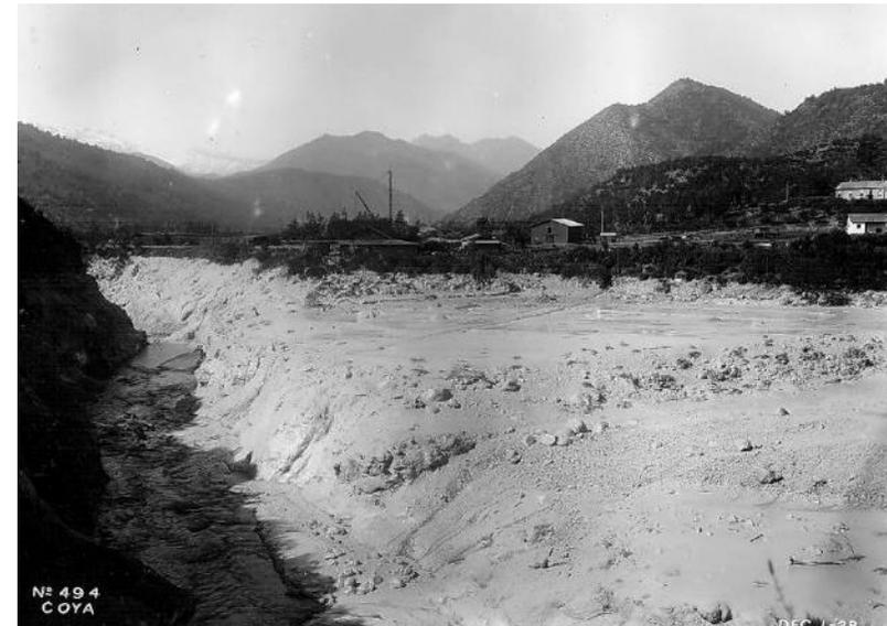
Figura 35: Relaves que se precipitaron sobre el río Coya, tras el terremoto del 1ro de diciembre de 1928.
