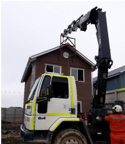
*Foto 14 Proceso de montaje de techumbre en vivienda. Constructora Manitoba, Puerto Montt. Fuente Elaboración propia.*
