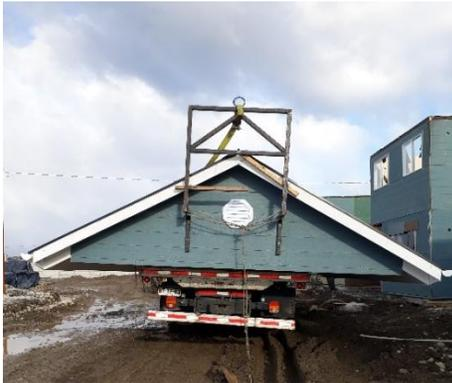
*Foto 13 Proceso de traslado de techumbre de vivienda. Constructora Manitoba, Puerto Montt. Fuente Elaboración propia.*
