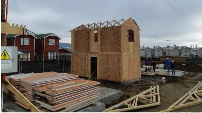
*Foto 10 Sistema casa prefabricadas con módulos de paneles SIP.
