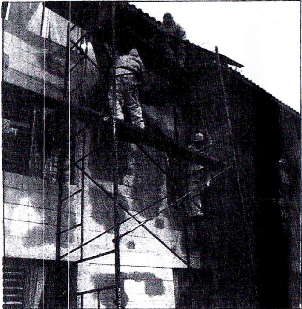
Con la instalación de mallas de kiur y canaletas en los techos, el Serviu pretende evitar la filtración de agua y humedad de las nuevas casas de la población Volcan San José.
