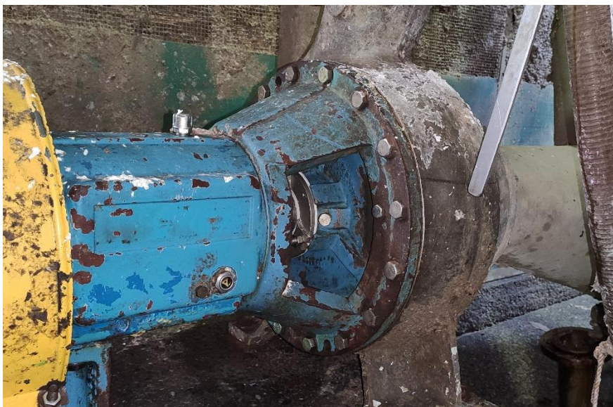
Figura 4.11: Bomba de descarga UP60
