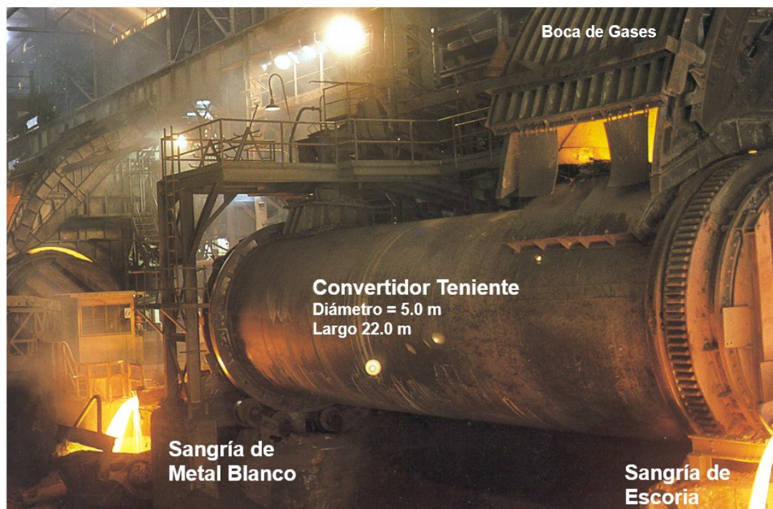
Figura 8. Vista del Convertidor Teniente (CT)
