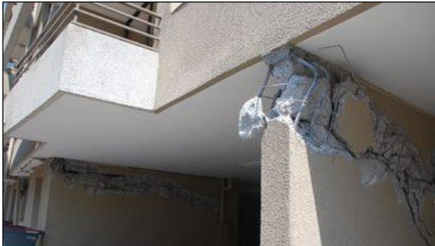
Figura 1.1. Falla en muro Edificio Regina Oriente, Terremoto 27F (2010), Chile.
