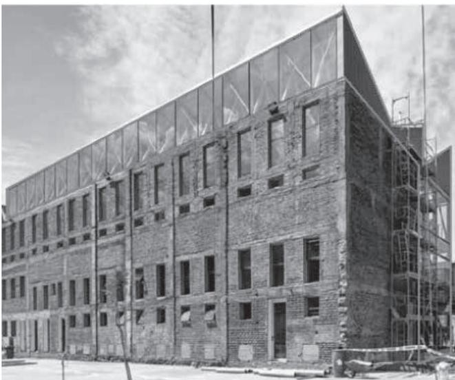
Figura 8. El Campus Creativo Universidad Andrés Bello, Schmidt Arquitectos, genera una ampliación superior contrastante recuperando el edificio con una cubierta de tipo industrial contemporánea coherente al uso anterior. Imagen intervenida. Fuente: [www.campuscreativo.cl](http://www.campuscreativo.cl)
