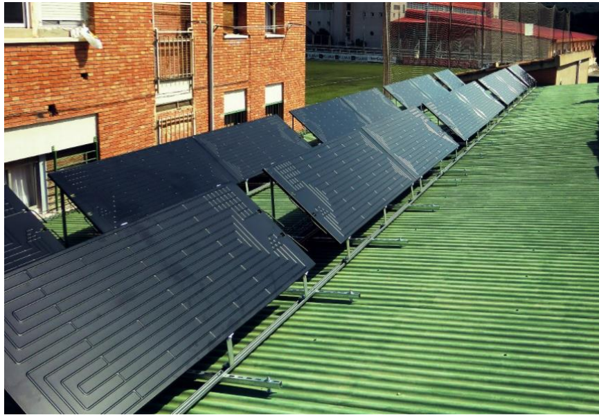
Figura 3.11: Instalación de un sistema PST.
