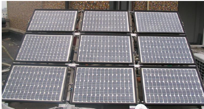
Figura 3.16: Módulos de evaporación PV-SAHP (sin vidrio).
