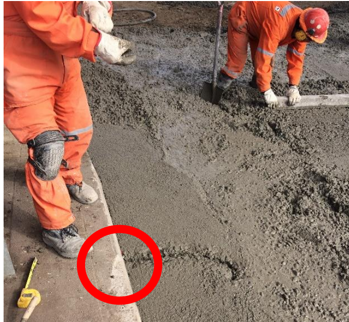
Figura 13: Colocación y Posición terminales Sensor Instrumentación C03
