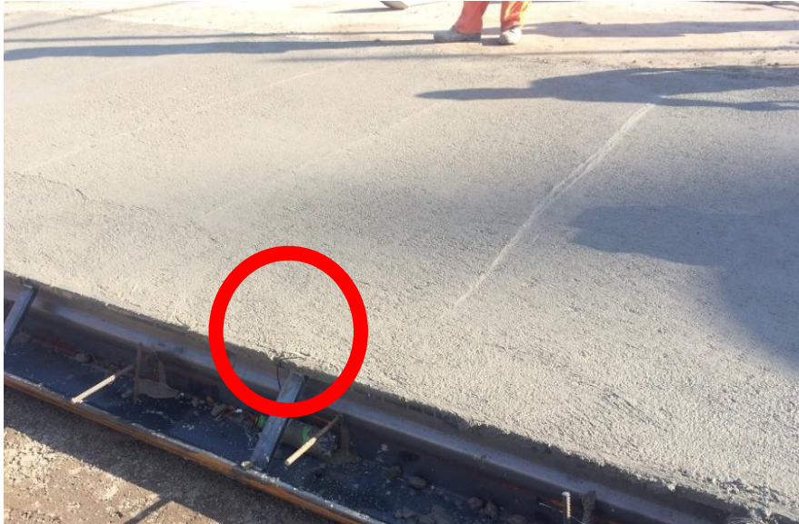
Figura 7: Posición terminales Sensor Instrumentación I02
