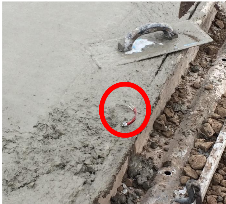
Figura 14: Posición terminales Sensor Instrumentación C04
