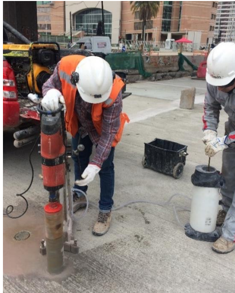
Figura 17: Extracción de testigos sensor instrumentación C01
