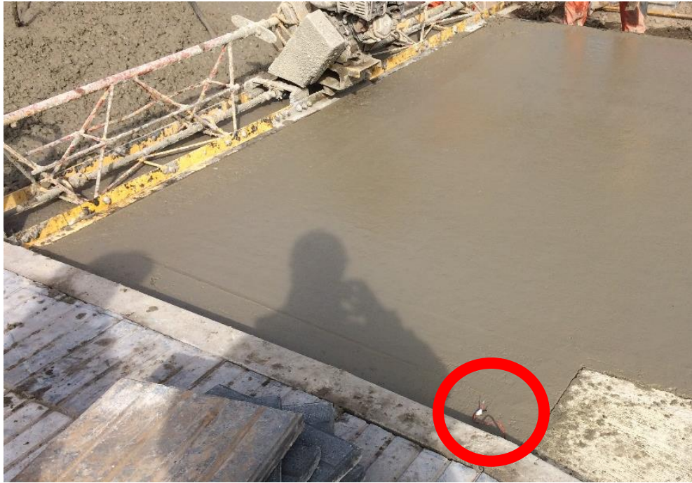
Figura 9: Posición terminales Sensor Instrumentación I04
