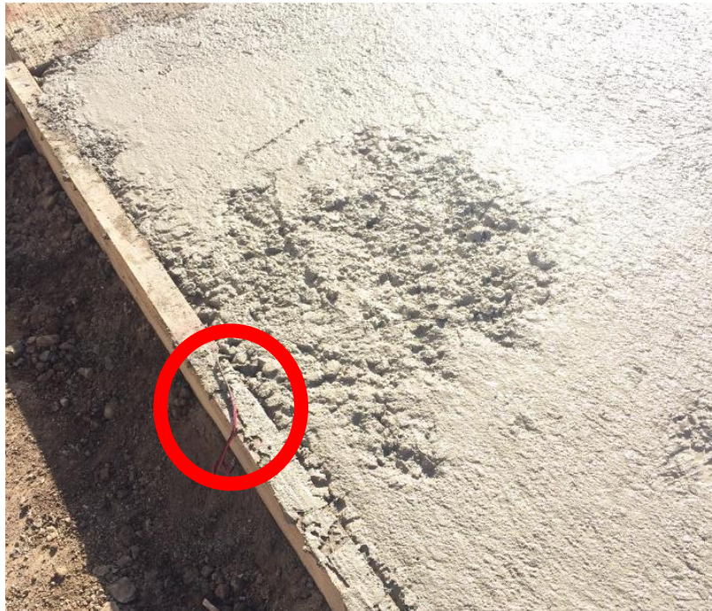
Figura 6: Posición terminales Sensor Instrumentación I01
