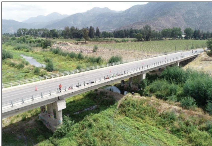
Figura 3-1: Vista General del Puente Águila Norte. Fuente: Fotografía proporcionada por Ramiro Bazález (UTFSM)
