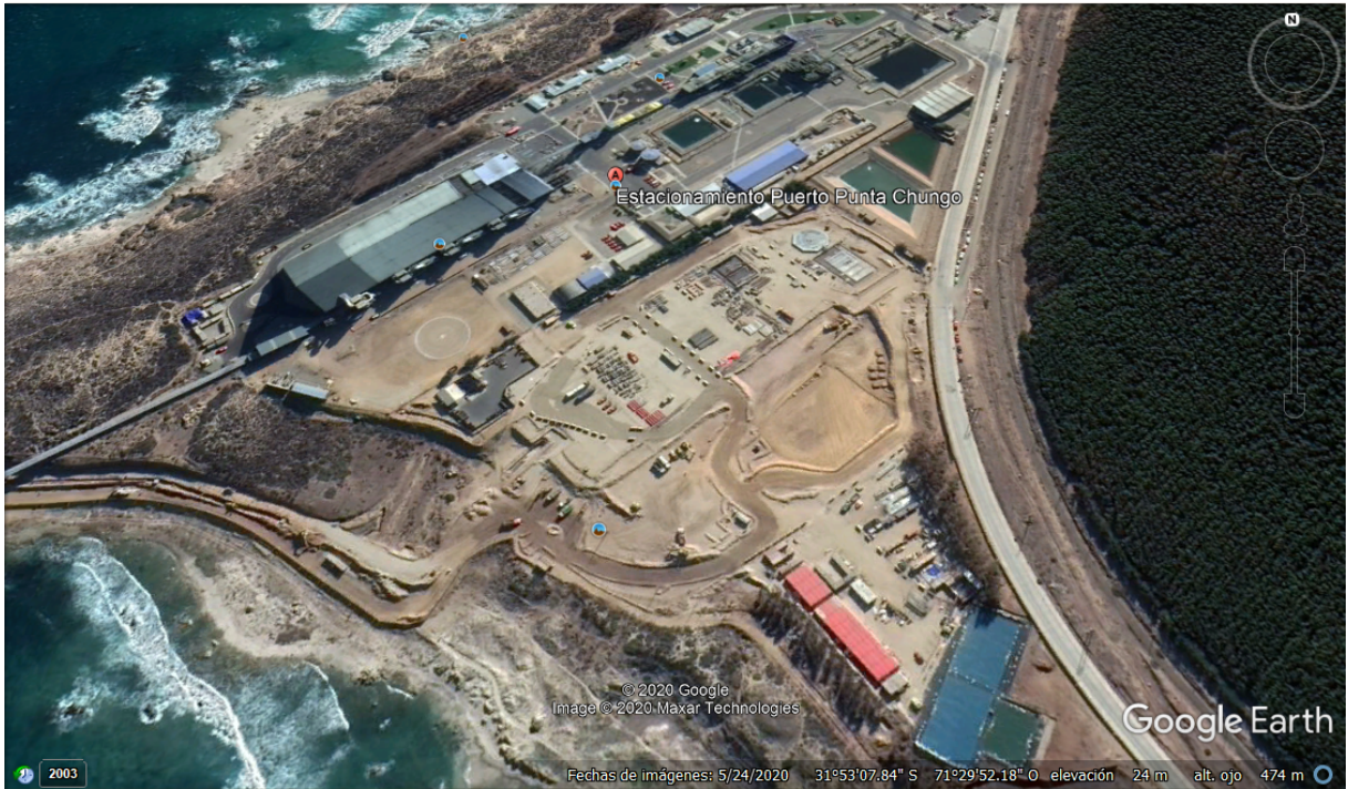
Figura A.2: Imagen satelital de Puerto Punta Chungo donde está en construcción la planta desalinizadora de MLP
