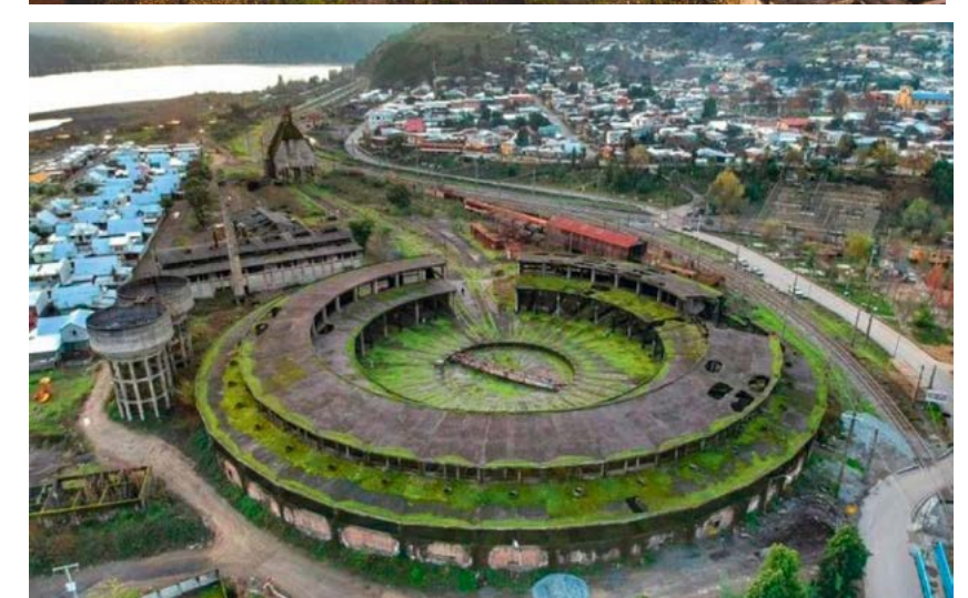
Imagen Superior Vista aérea sobre la Casa de Máquinas de San Rosendo Fuente: Pablo Araya - https://www.instagram.com/p/CC341TNhDtV/
