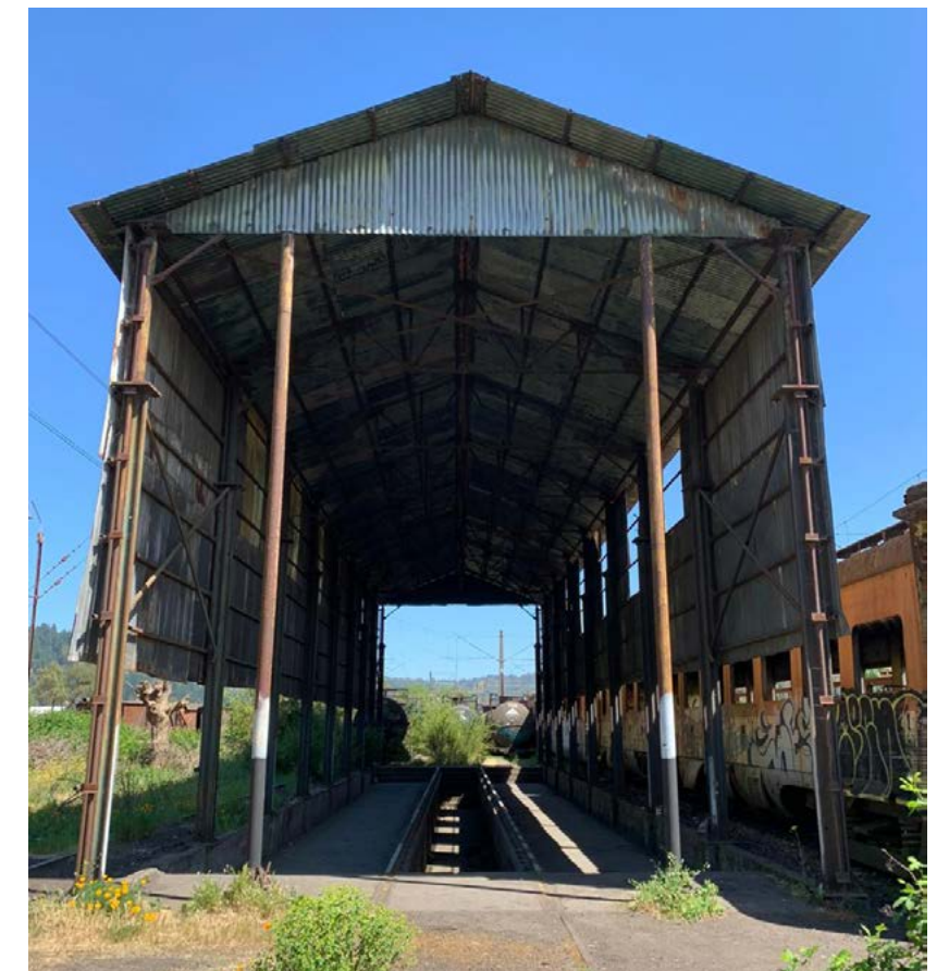
Imágenes Derecha Conjunto de imágenes referentes al estado actual de la Galpón de reparaciones Fuente: Archivo propio.
