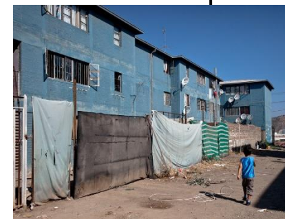
(Bajos de Mena, https://kilometrozero.cl/las-promesas-agrietadas-de-bajos-de-mena-eac5a61b710 )
