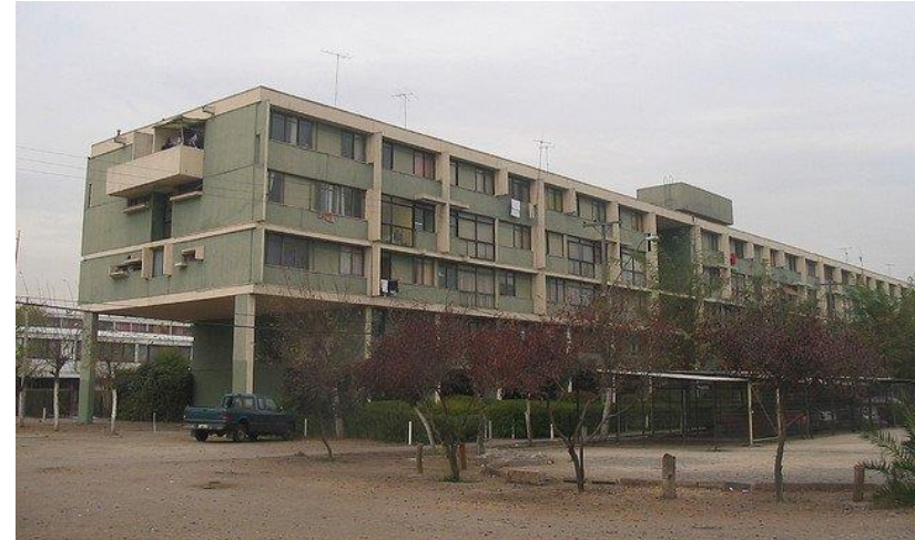
(Unidad Vecinal Portales, https://www.plataformaarquitectura.cl/cl/02-84819/clasicos-de-arquitectura-unidad-vecinal-portales-b-v-c-h?ad_medium=gallery )
