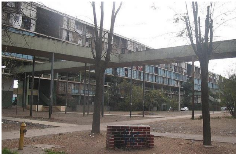
(Unidad Vecinal Portales, https://www.plataformaarquitectura.cl/cl/02-84819/clasicos-de-arquitectura-unidad-vecinal-portales-b-v-c-h?ad_medium=gallery )
