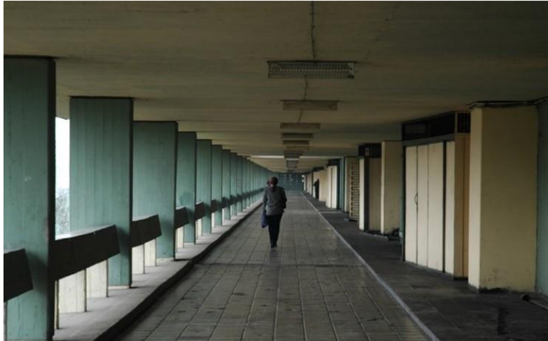
(Unidad Vecinal Portales, https://www.plataformaarquitectura.cl/cl/02-84819/clasicos-de-arquitectura-unidad-vecinal-portales-b-v-c-h?ad_medium=gallery )
