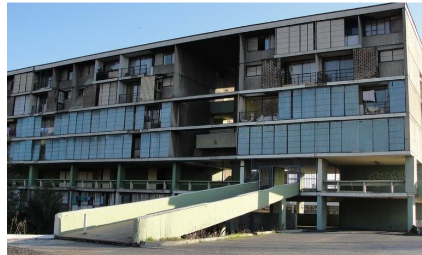
(Unidad Vecinal Portales, https://www.plataformaarquitectura.cl/cl/02-84819/clasicos-de-arquitectura-unidad-vecinal-portales-b-v-c-h?ad_medium=gallery )
