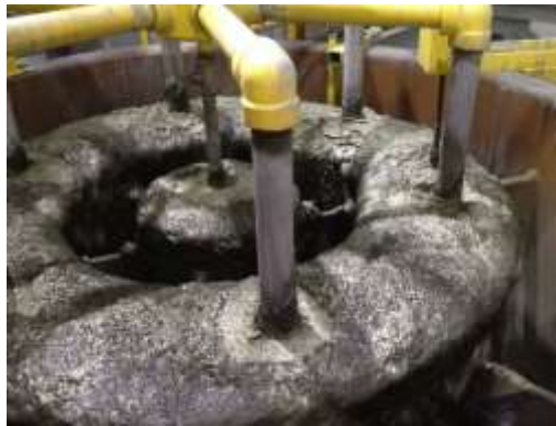
Figura 17: varias cámaras de flotación de SFR
