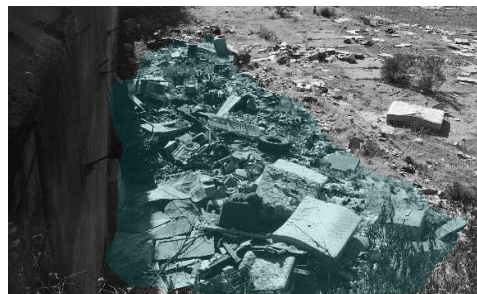
FIG. 26: ESCOMBROS Y BASURA EN TERRENO. FOTOGRAFÍA PROPIA
