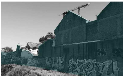
FIG. 25: ESPALDAS DE CONSTRUCCIONES NORTE. FOTOGRAFÍA PROPIA
