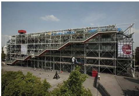
FIG. 13: CENTRE POMPIDOU EN LA ACTUALIDAD. EXTRAÍDO DE CENTREPOMPIDOU.FR
