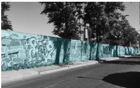
FIG. 22: MURO SEPARADOR TERRENO/ CALLE CHACABUCO. FOTOGRAFÍA PROPIA
