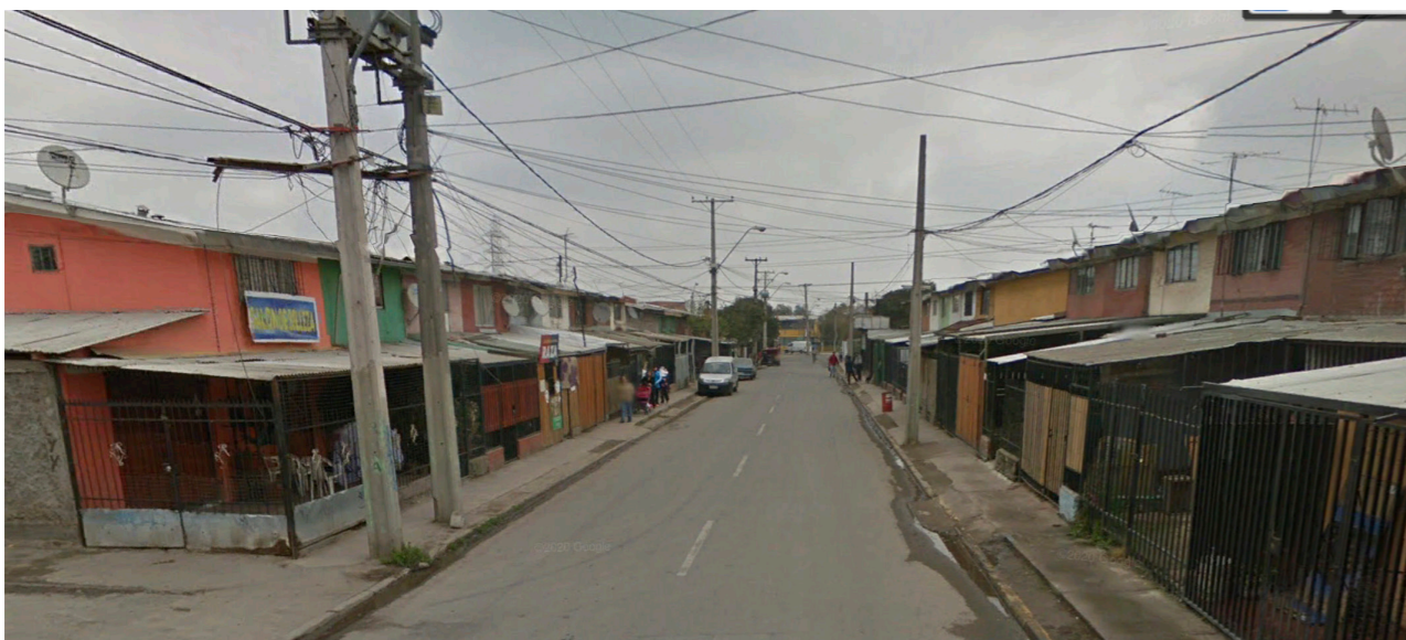
Calle Curaco de Velez, Bajos de Mena, Puente Alto
