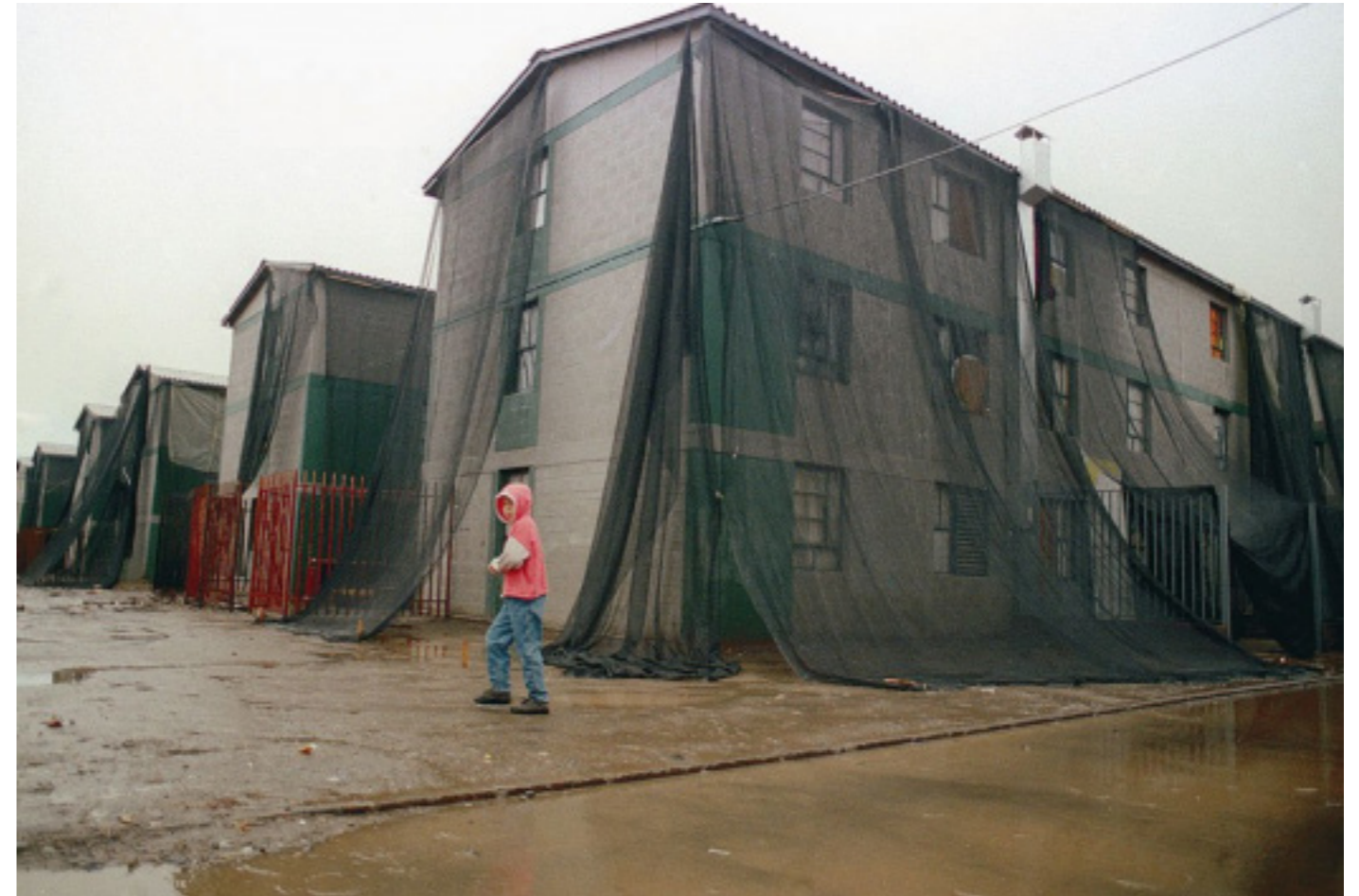
Casas Copeva, Bajos de Mena, Puente Alto.
