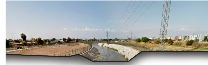
FIG. 20 Sección 6 Gran espacio fluvial circundante, presente como sitio eriazo Contexto de uso residencial Segregación espacial entre las áreas urbanas
