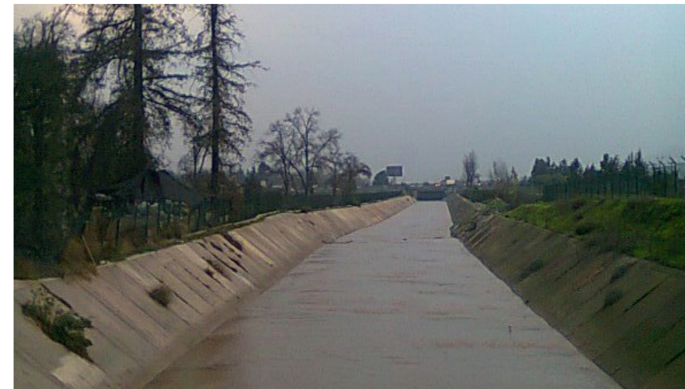
FIG. 56 Zanjón de la Aguada, sector Poniente, Maipú
