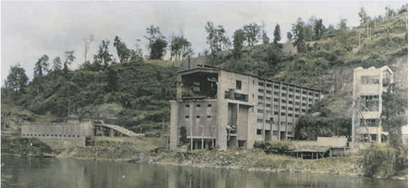
IMG.10_ Planimetrías originales de la Planta Carbonífera de CORFO, Secciones (1959). Fuente: El Proyecto Pupunahue de la Corporación de Fomento .
