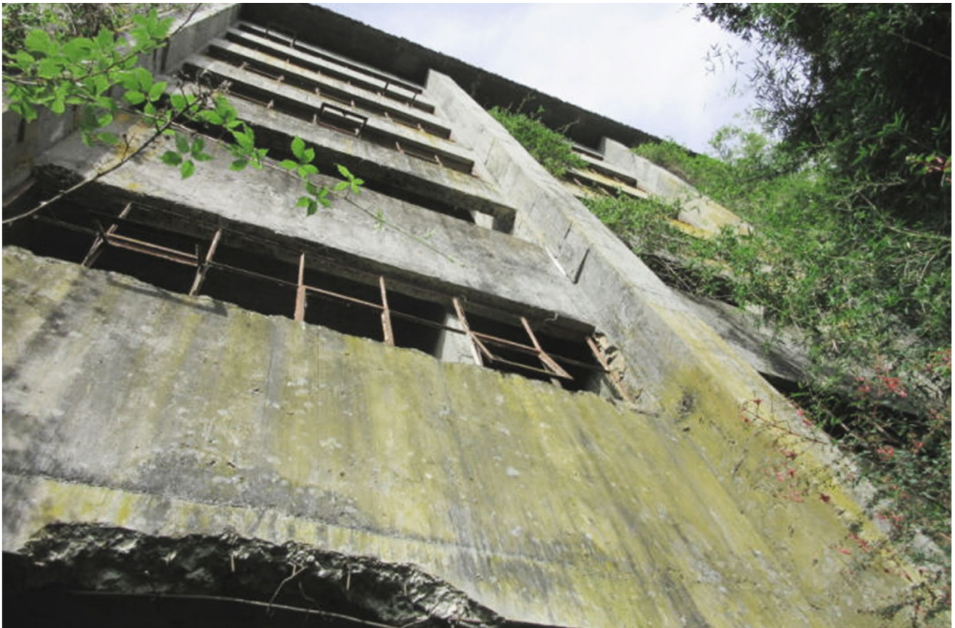
IMG.22_ Detalle Fachada Nororiente del Edificio Principal. Fuente: http://patrimonio.bienes.cl/patrimonio/ruinas-de-pupunahue/
