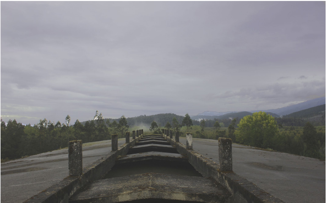
IMG.18_ Vista desde el la cubierta del Edificio Principal. Fuente: Archivo de Expedientes, CMN Los Ríos.
