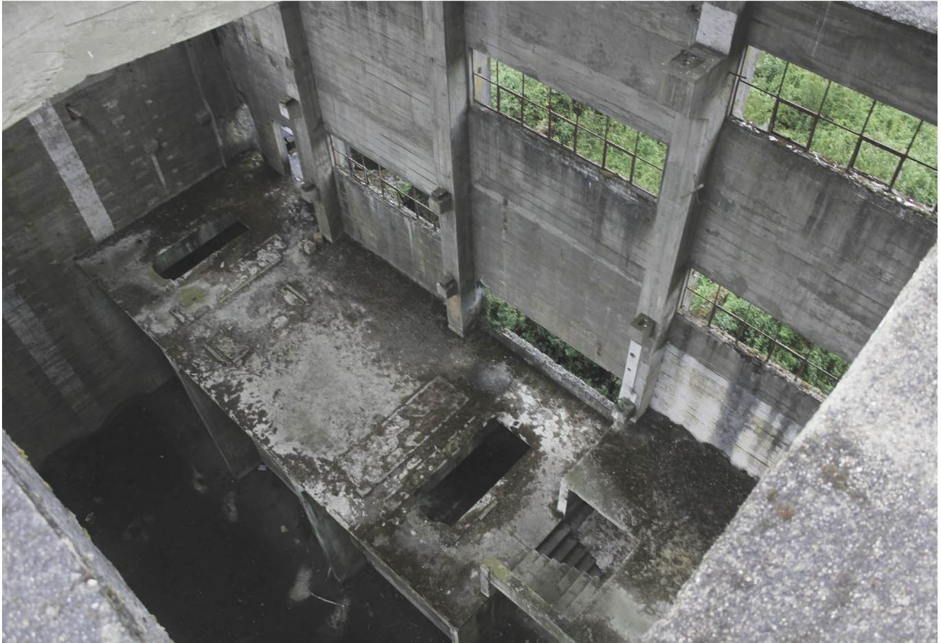
IMG.15_ Vista desde el Río Calle Calle del edificio principal de las Ruinas Carboníferas de Pupunahue. Fuente: Archivo de Expedientes, CMN Los Ríos.
