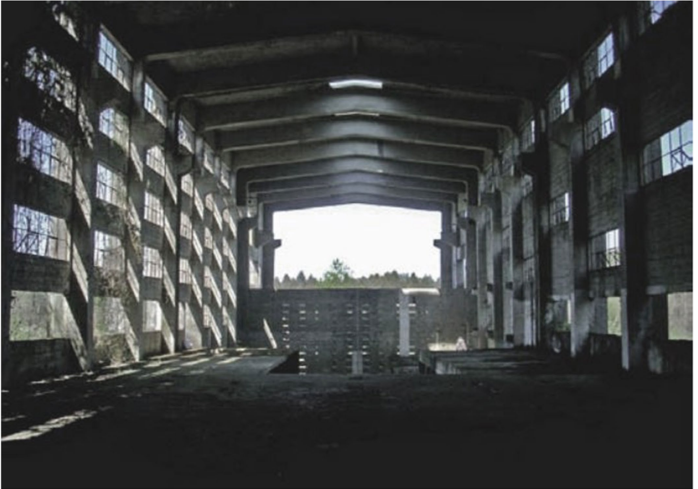
IMG.02_ Vista desde el interior, losa superior preexistente.
