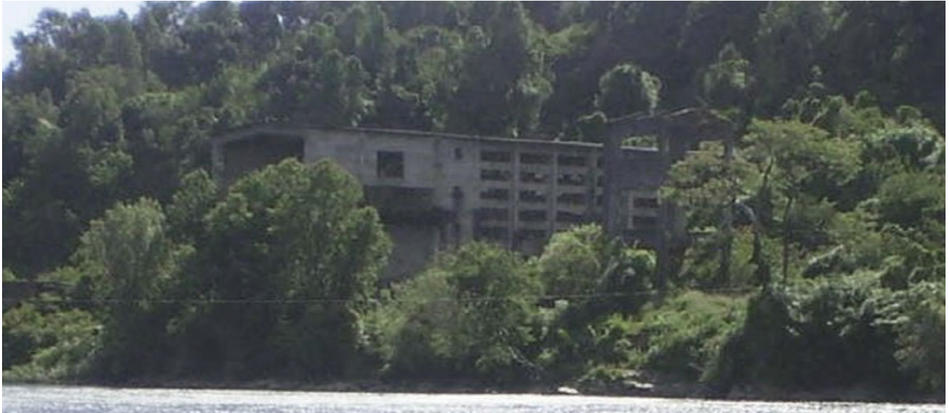
IMG.23_ Vista desde el Río Calle Calle del Edificio Principal y Torre e Agua, 2016. Fuente: http://cybertesis.uach.cl/tesis/uach/2010/fcib195r/doc/fcib195r.pdf
