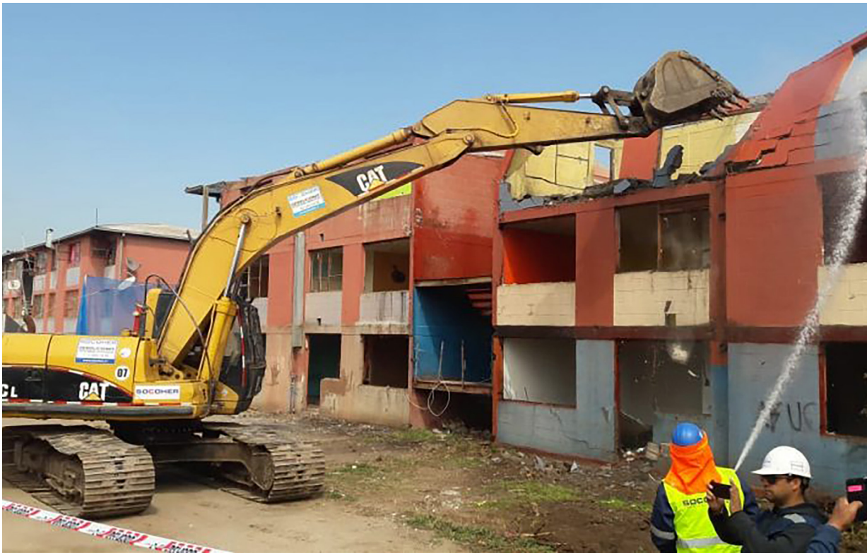
Figura 9. Programa Segunda Oportunidad. Demolición dos blocks en la Villa Marta Brunet. Sector Bajos de Mena. Comuna de Puente Alto. Fuente: Bajos de Mena Radio.
