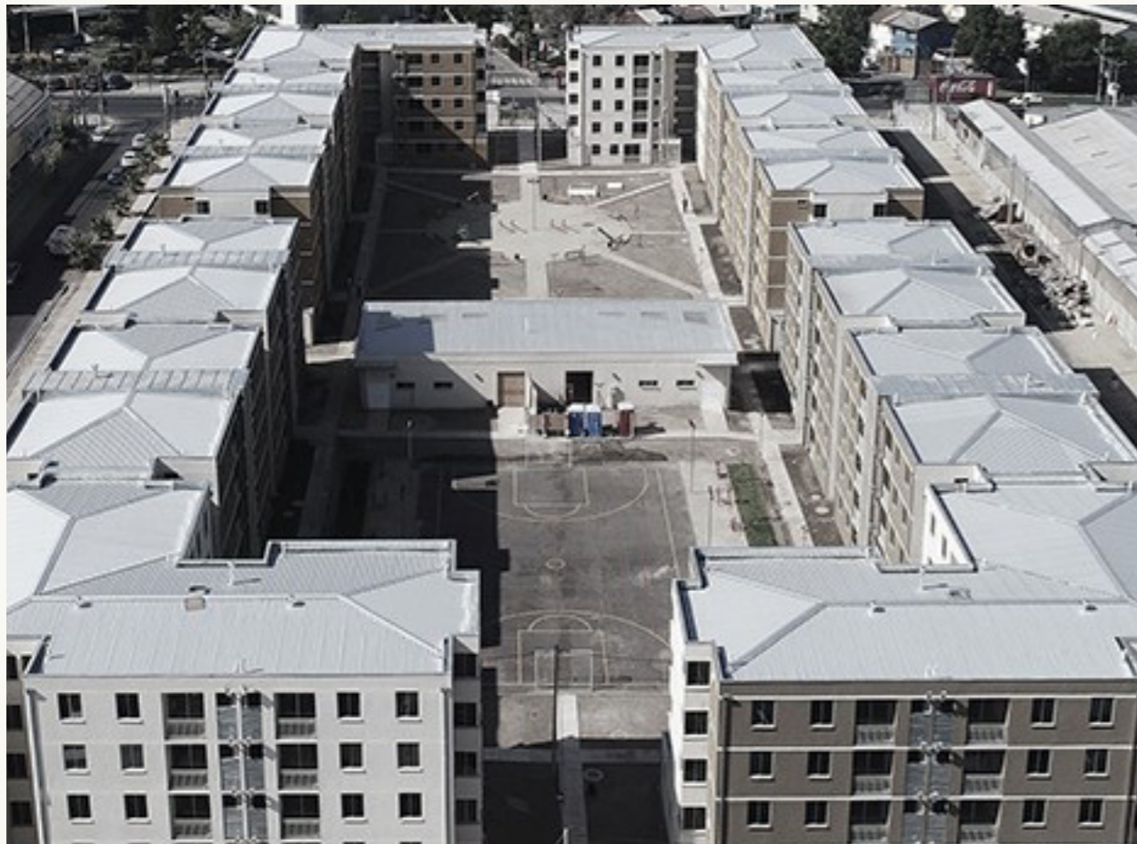
Imagen N°15: Proyecto Rivas III y IV en Comuna de San Joaquín | Fuente : Constructora OVAL.
