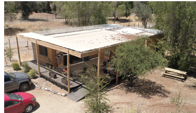
Imágen n°50_Infraestructura multiuso en Humedal Laguna de Batuco Fuente: Archivo Fotográfico Enero 2021 _ Jorge Jorquera Castillo
