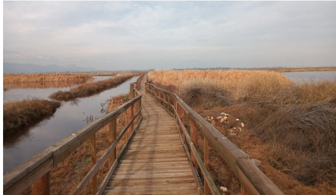
Imágen n°47_Pasarelas Fundación San Carlos de Maipo Fuente: Archivo Fotográfico Propio_Agosto 2020
