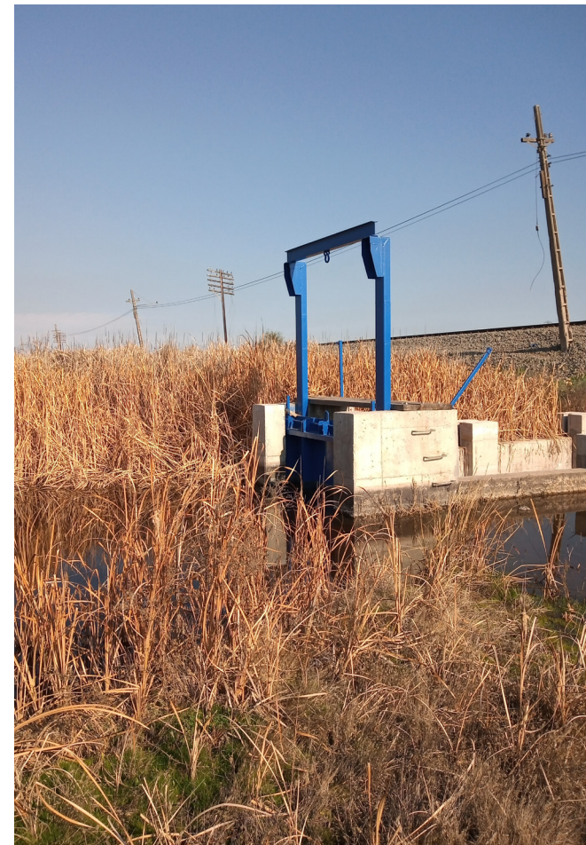
Imágen n°24_Compuertas de extracción de aguas por motobomba Fundo La Laguna Fuente: Archivo Fotográfico Propio_Julio 2020
