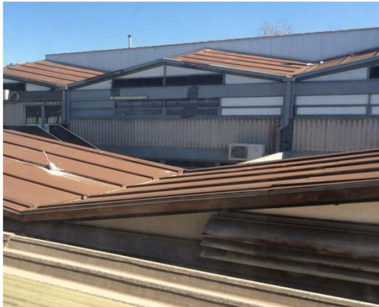
*Solución doble cubierta a filtración aguas lluvia*
