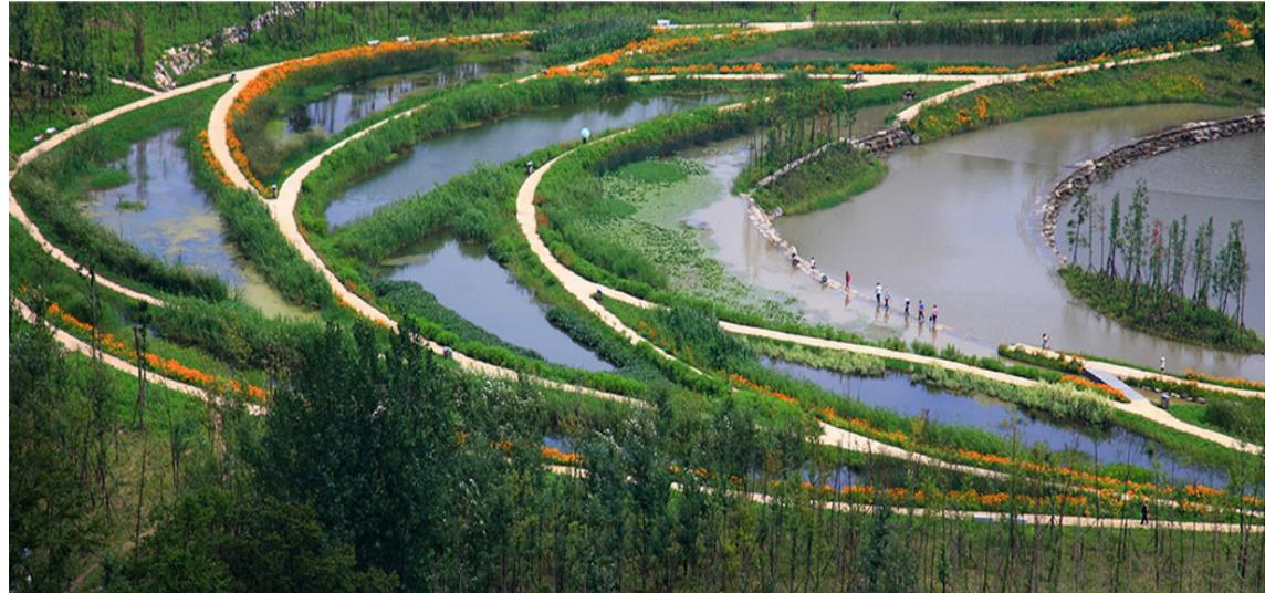
Figura 52. Laminas de agua. se busca reducir la velocidad del flujo de agua de las laderas y crear una infraestructura a base de agua que retenga y remedie el agua de lluvia, y hacer que el agua sea el agente activo en la regeneración del ecosistema. Fuente: <https://www.plataformaarquitectura.cl/cl/764388/parque-del-humedal-minghu-turenscape>
