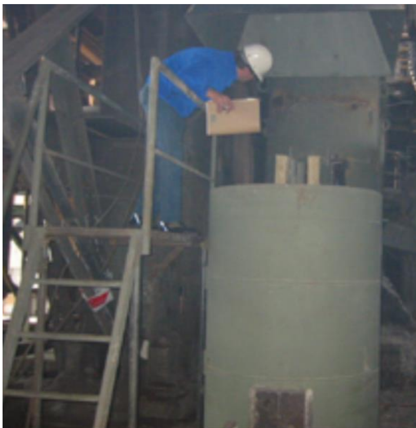
Figura 51 Horno de reducción de lecho empacado
