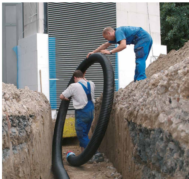
Figura 4.14: Tubería UPONOR Ecoflex preaisladas para distribución [57]
