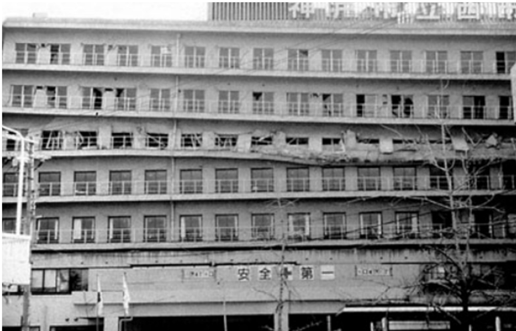
Fotografía N°1: Colapso del Quinto piso, Hospital de Kobe, 1995
