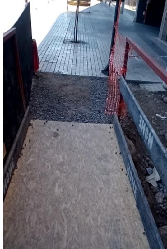
Figura 43. Construcción sobre vereda. Elaboración propia
