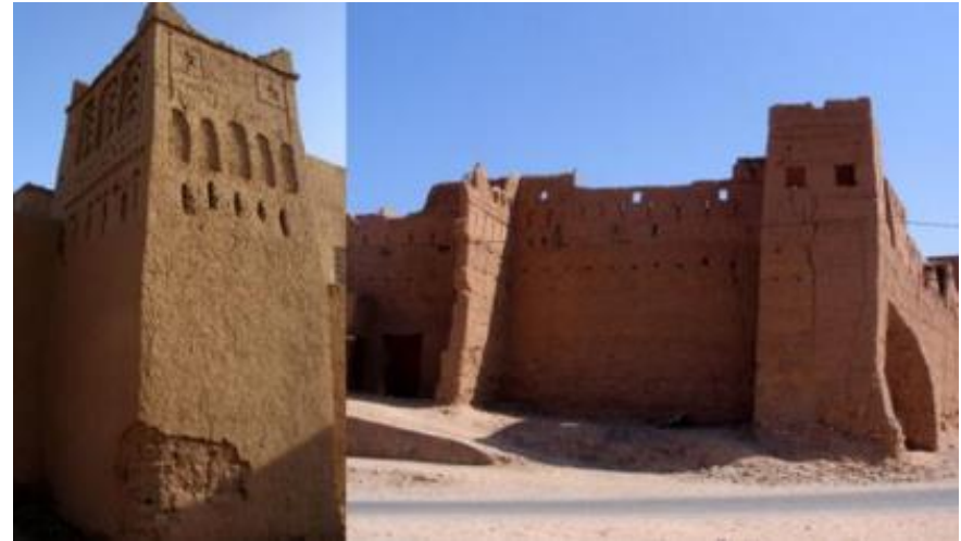
Figura 10. Construcciones en tapial en el valle de Draa, Marruecos. Fuente: (Baglioni et al., 2012)
