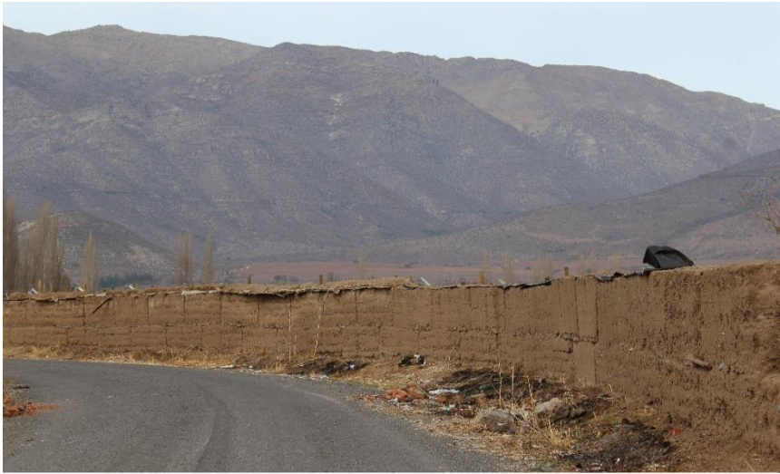
Figura 207. Presencia de microbasurales. Fuente: Elaboración propia.
