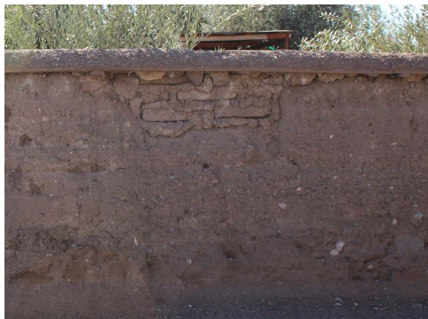
Figura 120. Reparación con adobes. Fuente: Elaboración propia.
