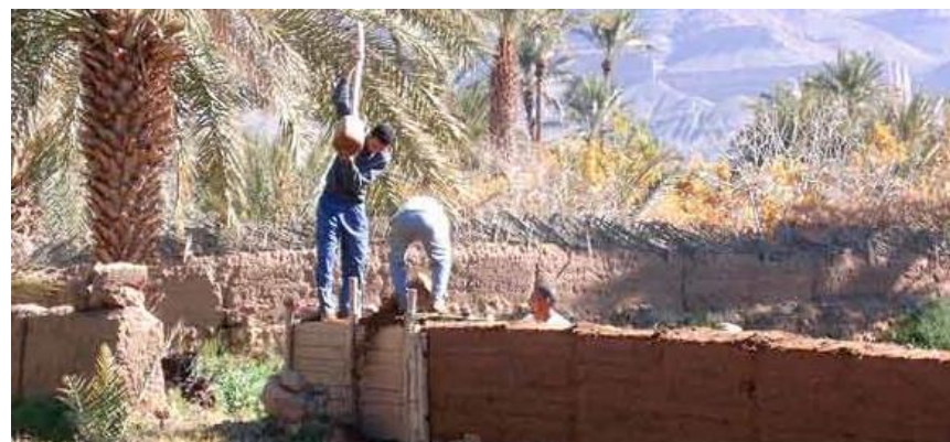
Figura 12. Tapia en construcción en el valle de Draa, Marruecos. Fuente: Celtiberia (2007).
