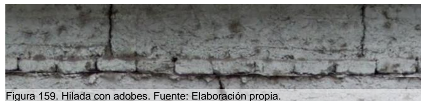
Figura 159. Hilada con adobes. Fuente: Elaboración propia.
