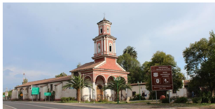
Figura 61. MH Iglesia San Francisco de Curimón. Fuente: Elaboración propia.
