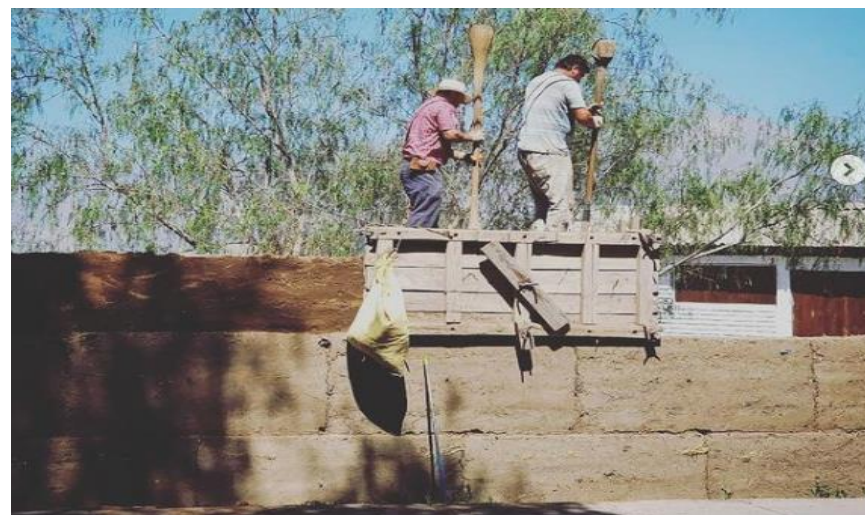
Figura 71. Tapias en construcción en la comuna de Santa María en octubre de 2020. Fuente: Colaboración de Sergio Rojas.
