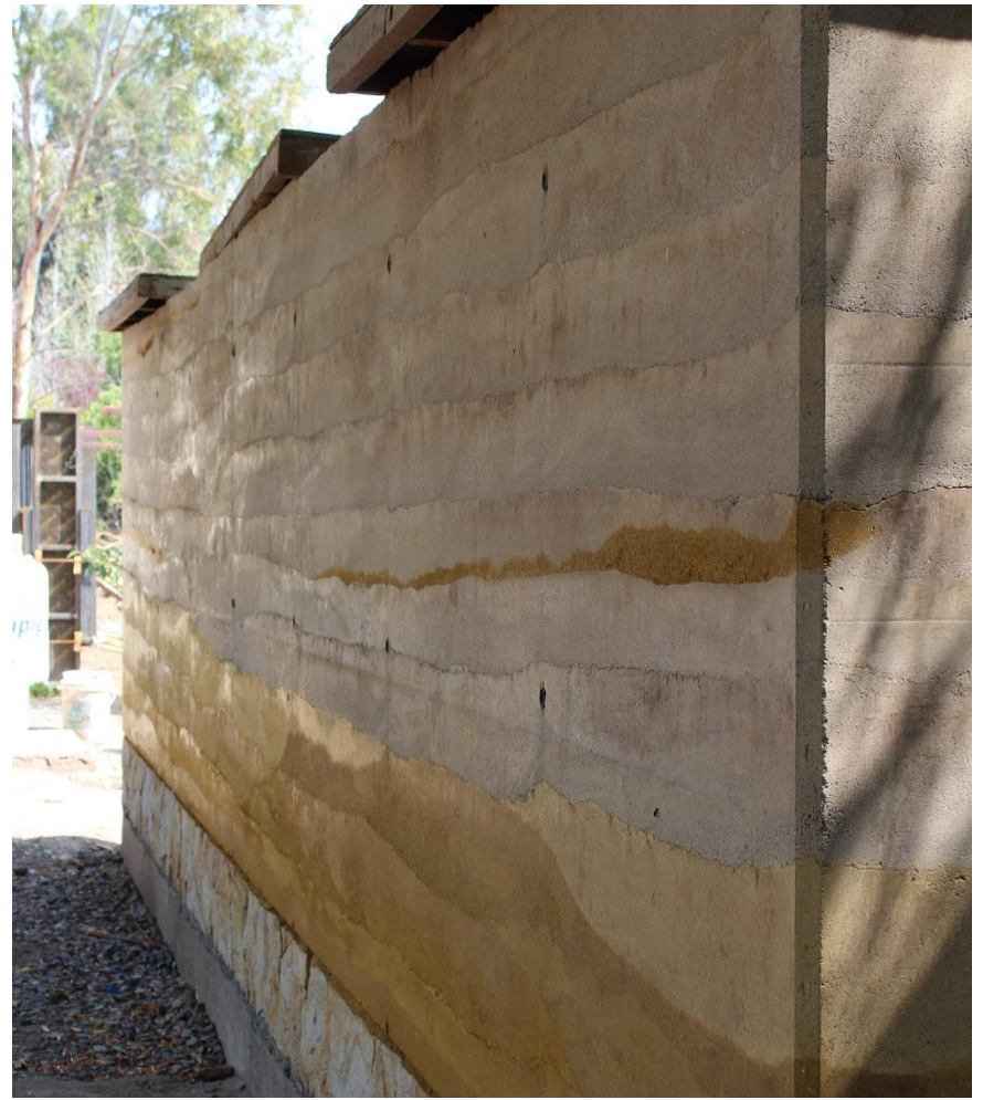
Figura 126. Tapia calicostrada. Fuente: Elaboración propia
