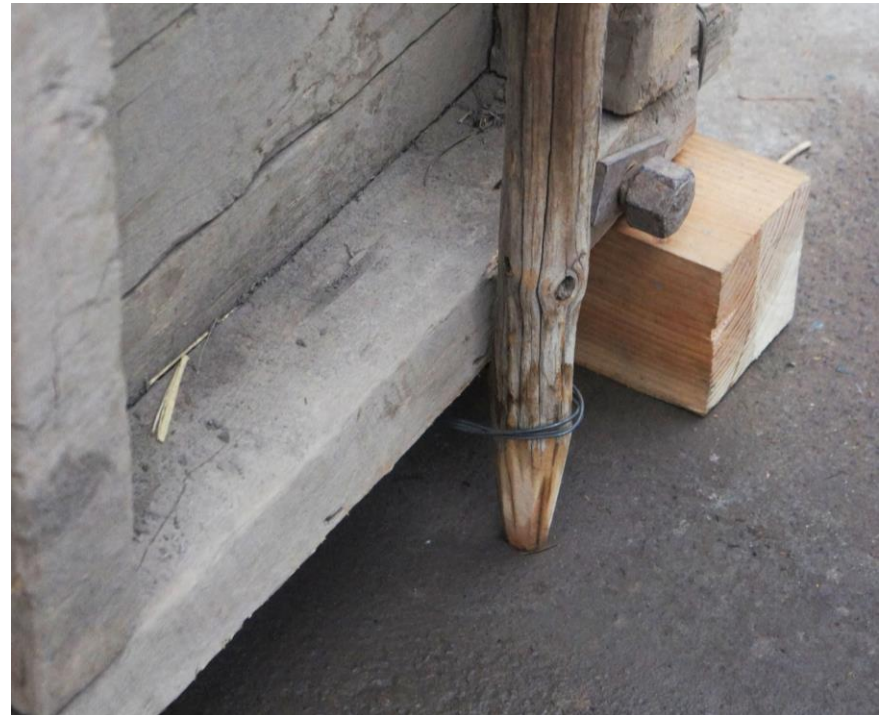
Figura 108. Estacón y traba de alambre. Fuente: Colaboración de Valentina Baffico.
