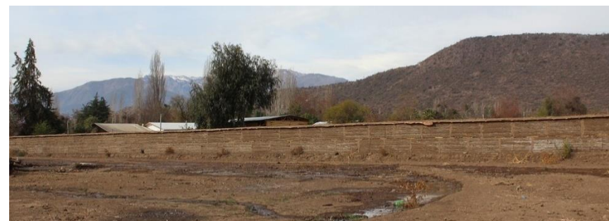
Figura 212. Tapias que minimizan el impacto visual de edificaciones discordante. Fuente: Elaboración propia.
