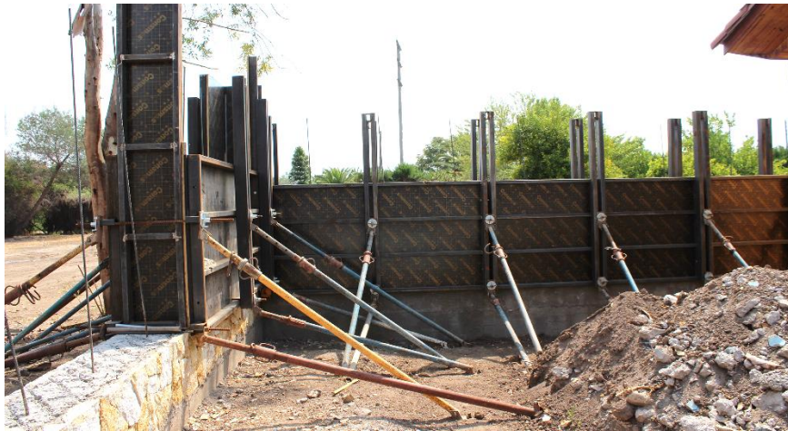
Figura 123. Moldaje tapia calicostrada. Fuente: Elaboración propia.
