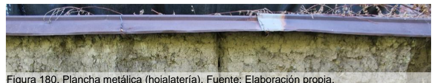
Figura 180. Plancha metálica (hojalatería). Fuente: Elaboración propia.
