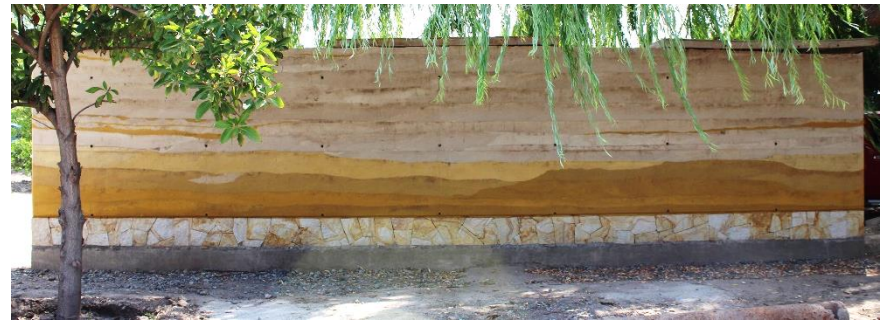
Figura 125. Tapia calicostrada. Fuente: Elaboración propia.
