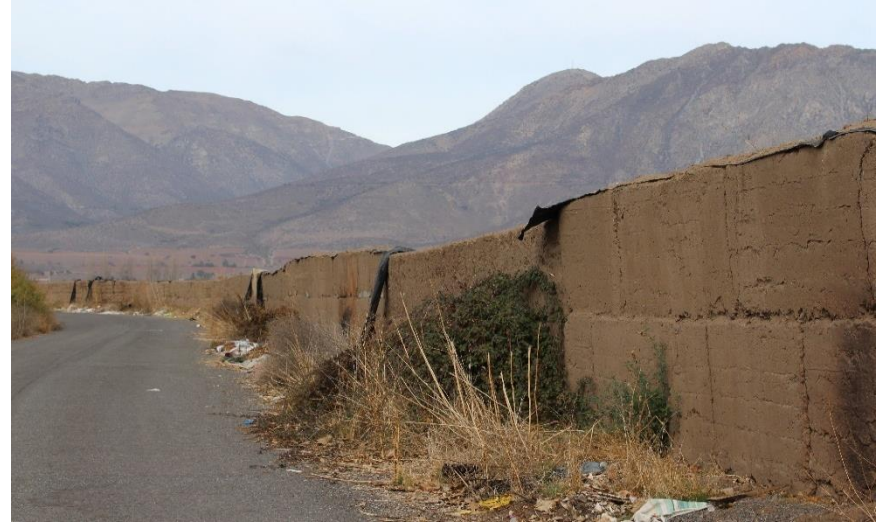
Figura 208. Presencia de microbasurales. Fuente: Elaboración propia.
