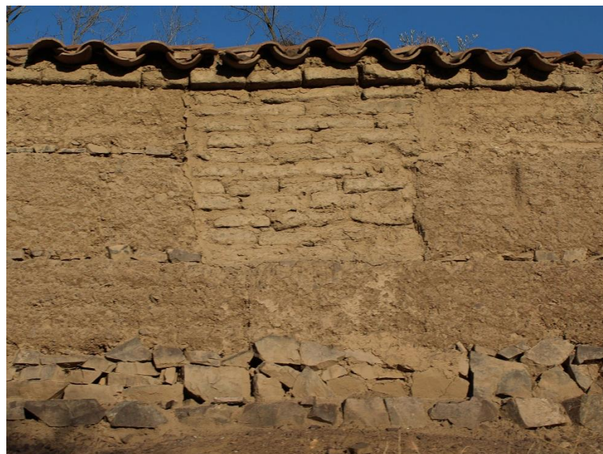
Figura 119. Reparación con adobes. Fuente: Elaboración propia.
