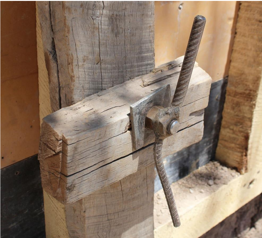
Figura 106. Tranquilla del tapial. Fuente: Elaboración propia.
