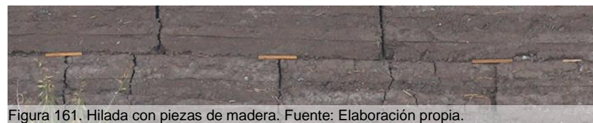
Figura 160. Hilada con piezas de madera. Fuente: Elaboración propia.
