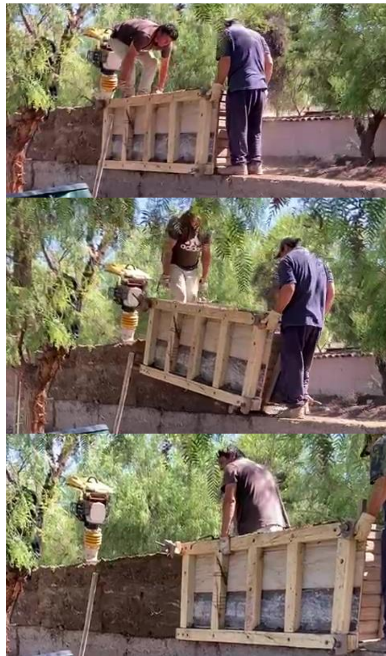
Figura 111. Proceso de apertura y desplazamiento horizontal del tapial. Fuente: Elaboración propia.
