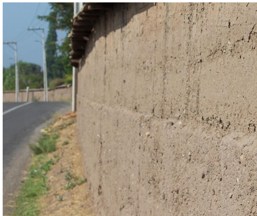
Figura 114. Tapia con terminación a la vista. Fuente: Elaboración propia.
