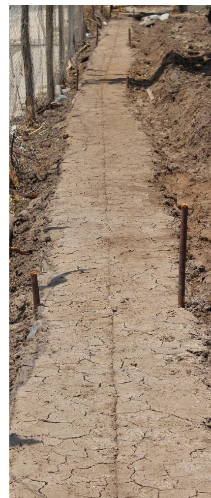
Figura 97. Cimiento ejecutado. Fuente: Elaboración propia.
