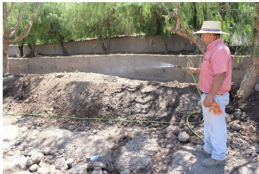
Figura 102. Humedecimiento de la tierra. Fuente: Elaboración propia.
