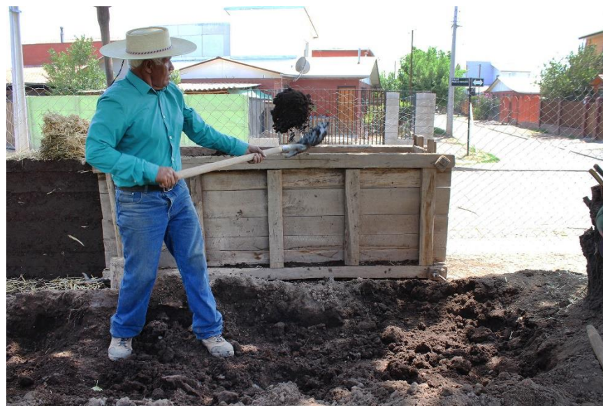
Figura 109. Llenado del tapial. Fuente: Elaboración propia.
