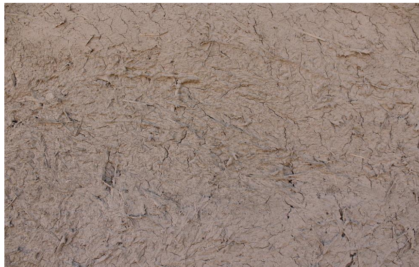
Figura 115. Terminación en revoque de tierra. Fuente: Elaboración propia.
